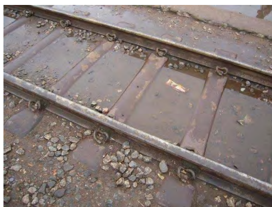
図 3-12 バラストが十分入っていない軌道
