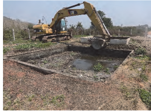
バックホーによる浚渫状況 (参考：VTE KM32 例)
