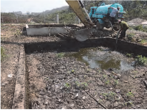
バキューム車による液状物の吸い込み状況 (参考：VTE KM32 例)
