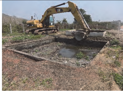
バックホーによる浚渫状況 (VTE KM32)
