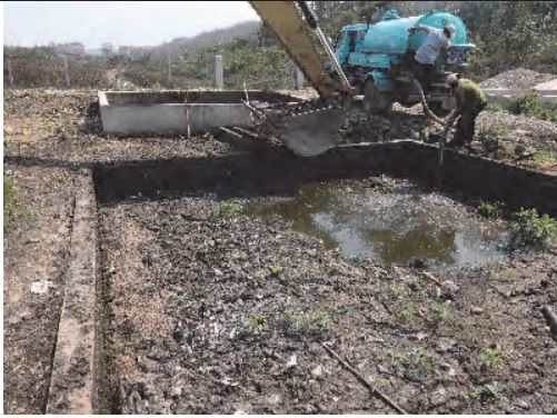
バキューム車による液状物の吸い込み状況 (VTE KM32)
