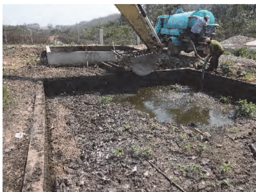
バキューム車による液状物の吸い込み状況
