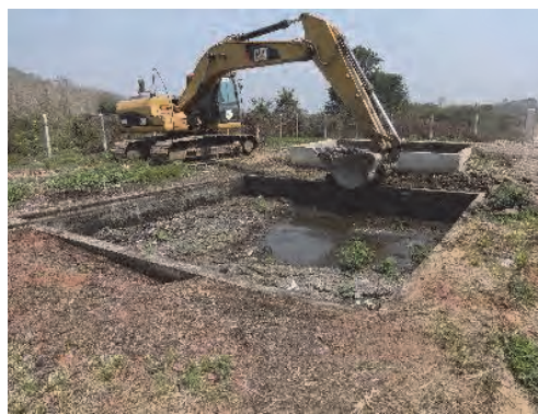
バックフォーによる浚渫状況
