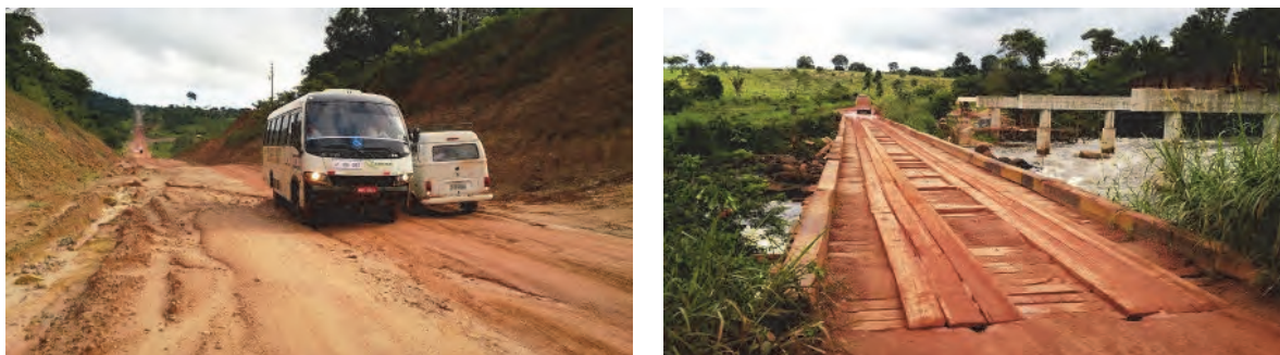
(Esq.: Trecho não asfaltado perto de Rurópolis Dir.: Ponte não concluída perto do km. 289 (1 pista)
