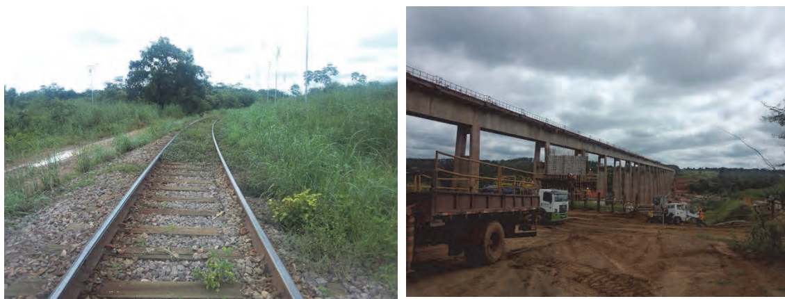
Figura 5.3.1 Ferrovia Norte-Sul (esq.) e Ferrovia Carajás (dir.: trecho em construção de trilhos duplos)
