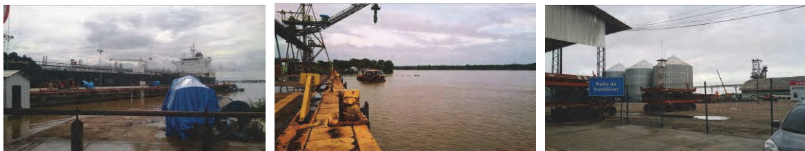
図 5.1.16 サンタナ港現況（2015 年 3 月 20 日調査団撮影）
