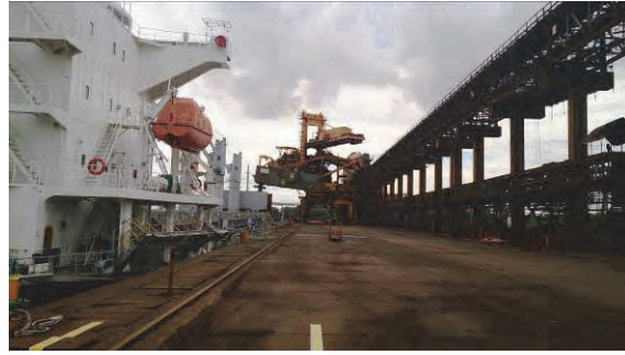
図 5.1.4 バース No. 105 状況 (2015 年 3 月 23 日調査団撮影)
