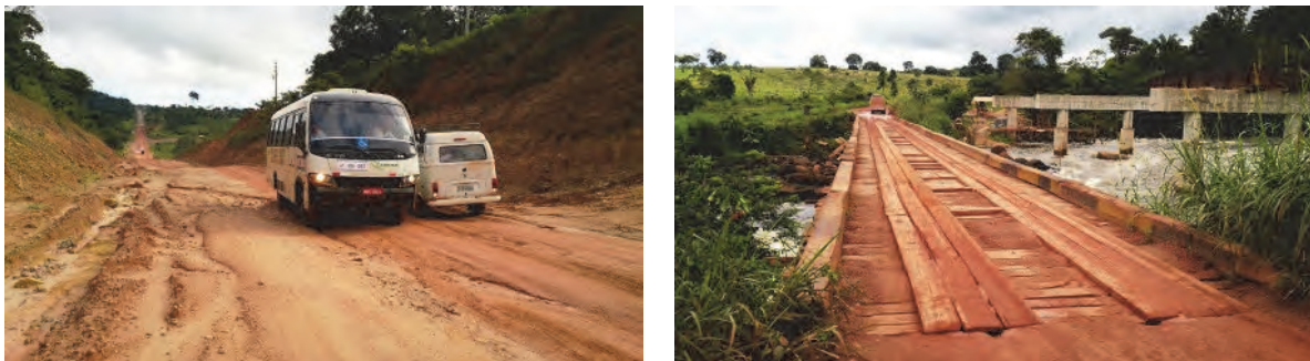
(左：Ruropolis 付近の未舗装区間、右：289km 付近の木橋（1 車線）)
