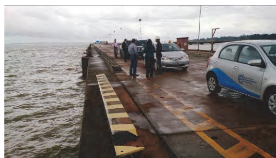
図 5.1.23 オウテイロ港現況 (2015 年 3 月 12 日調査団撮影)
