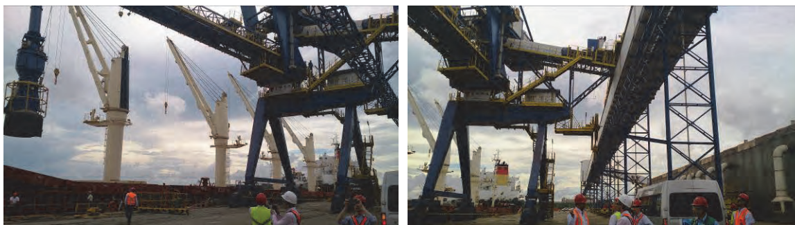
図 5.1.1 バース No. 103 状況 (2015 年 3 月 23 日調査団撮影)
