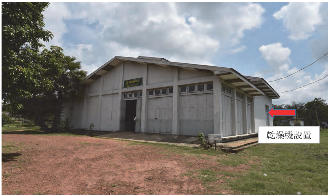
写真 4-01 : 乾燥機設置予定場所
