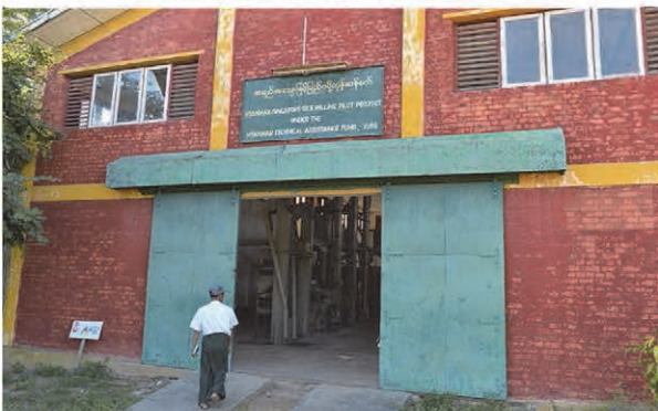
センター内に設置されている精米施設建屋
