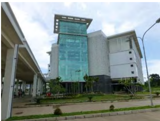
円借款で建設されたハサヌディン大学工学部施設 （南スラウェシ州ゴワ県スグミナサ市）
