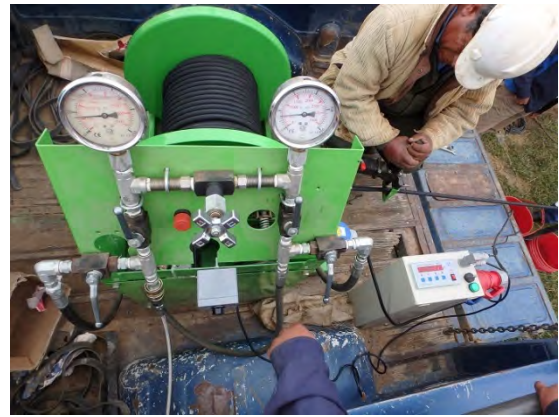
改修装置（衝撃波法）
