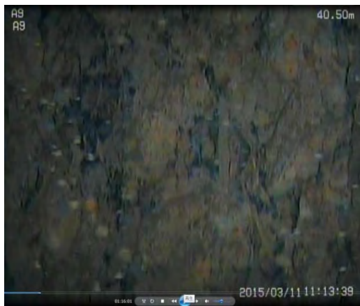
井戸スクリーン（改修前）
