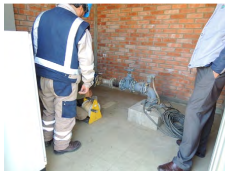
B6 井小屋内部
