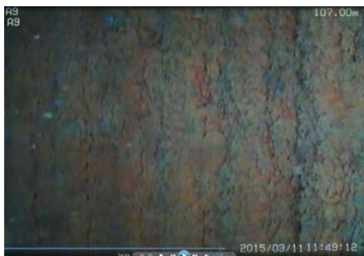
井戸スクリーン（改修前）
