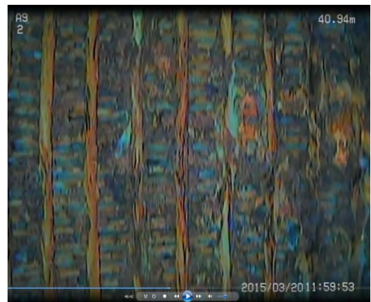
井戸スクリーン（改修後）
