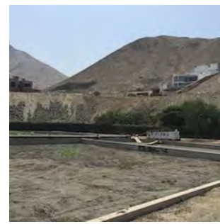
汚泥乾燥用の敷地
