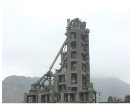
国内最大のセメント会社 UNACEM の セメント製造設備
