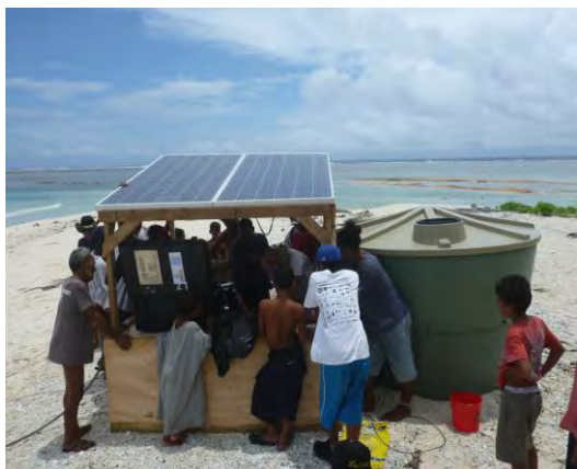
離島に設置された海水淡水化装置
