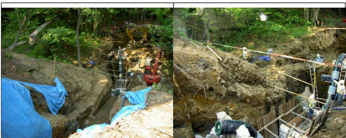
河川横断部でのパイプライン埋設作業の例（日本の事例）
