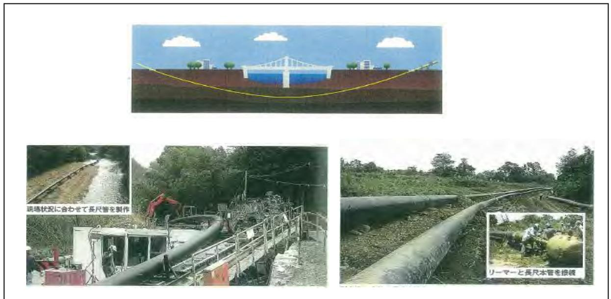
図 2.4-51 HDD 工法（例）
