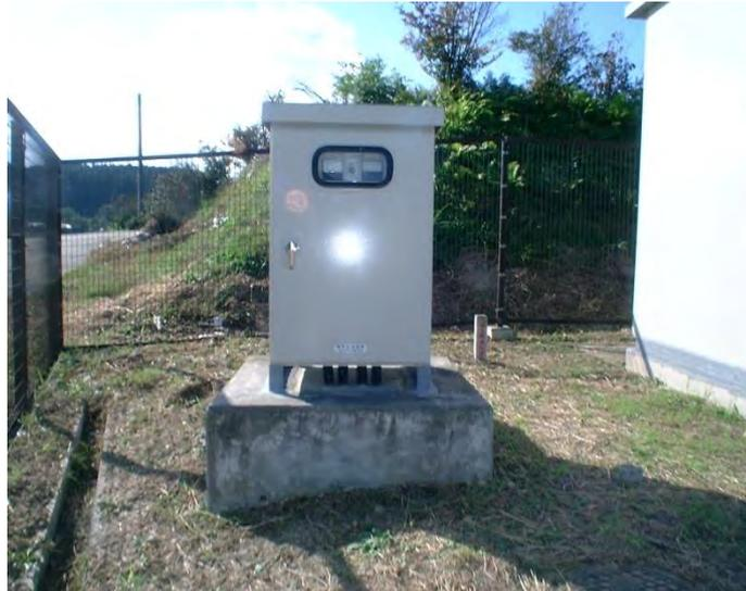
図 2.4-23 電気防食装置の設置 (例)
