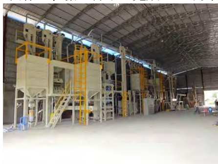
建屋の後方から見た精米ライン
