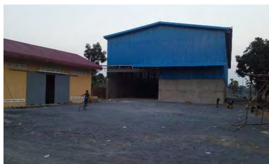
完成した建屋（左：事務所、右：精米所）
