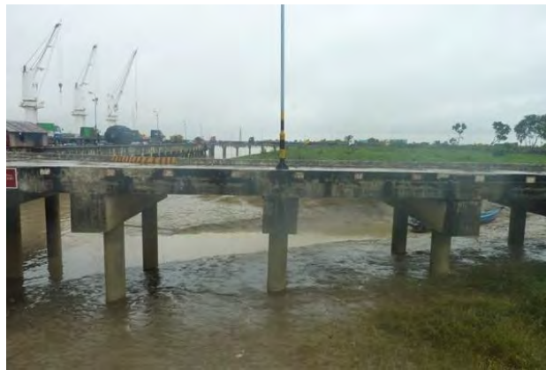
図 5.4-49 離隔型の岸壁が採用された MITT の現況 (2)
