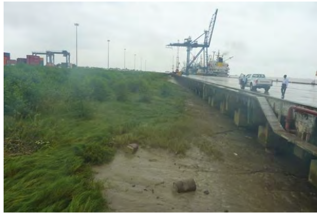
図 5.4-48 離隔型の岸壁が採用された MITT の現況 (1)
