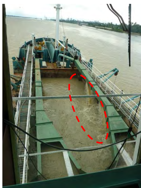
図 3.4-7 浚渫作業の様子 (2012.9.28)
