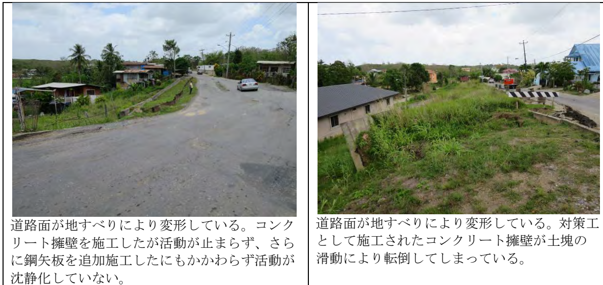
図 2.10.8 トリニダード島南部のサン・フランシスクで発生している道路地すべり被害
