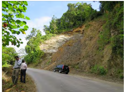
図 2.10.7 トリニダード島北部の海岸道路に認められる斜面崩壊跡
