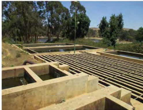
S.V W.T.P Flocculation basin
