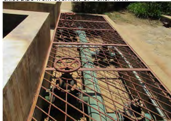
S.V W.T.P Inlet pipe
