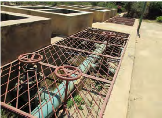
S.V W.T.P Inlet pipe
