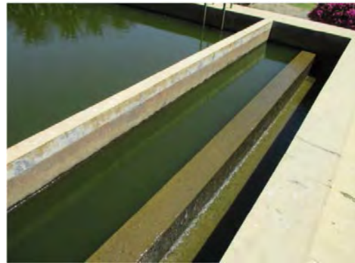
S.V W.T.P Outlet of sedimentation
