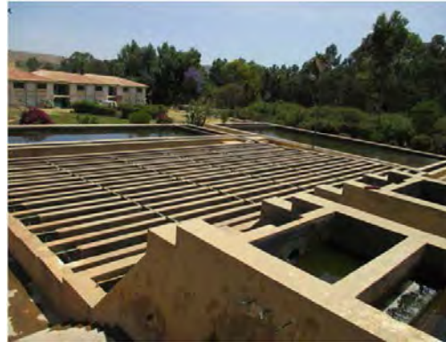
S.V W.T.P Flocculation basin
