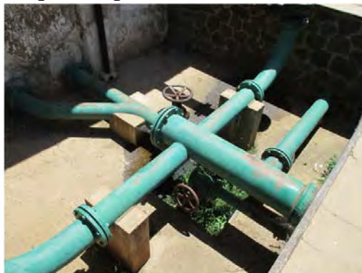
S.V W.T.P Back-wash pipe
