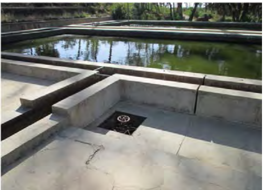
S.V W.T.P Sedimentation
