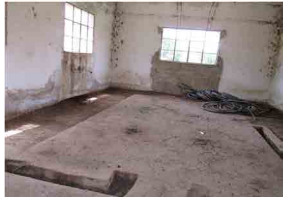
Mai Nefhi浄水場 発電機室 故障のため撤去。
