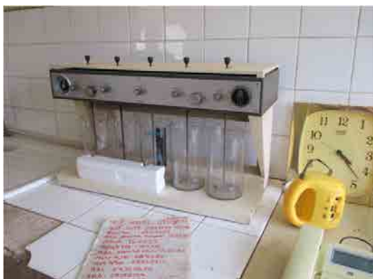
Mai Nefhi浄水場 ジャーテスト
