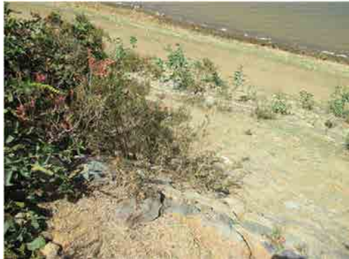
Valle Gneccchiダム 堤体の上流のり面 表面ロックでのり面を保護している。
