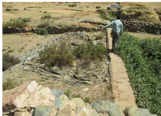
Valle Gneccchiダム 洪水吐 堤体の大きさと比較して規模が小さい。
