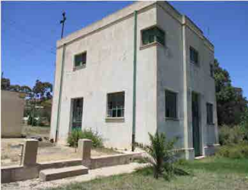
S.V浄水場 管理棟
