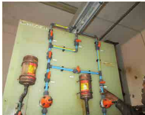
Toker浄水場 次亜塩素酸生成液のケミカル配管
