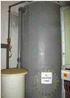
Toker浄水場 次亜塩素酸生成液タンク
