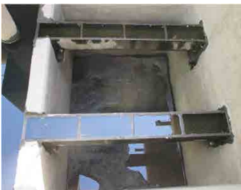
Toker浄水場 ろ過池 ろ床の状態。
