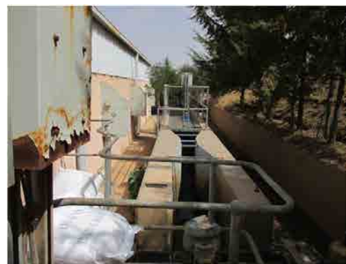
Toker浄水場 調整池からの流入口 パージアルフリュウム(流量調整)
