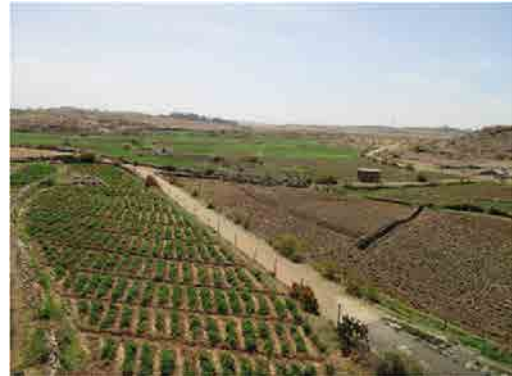
Ela Nahib (Adi Nefas)ダム 堤体の下流側 取水施設があるが現在未使用。
