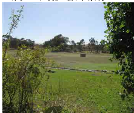
S.Vダム ダム湖内の堆積 ダム湖内の堆積は顕著である。
