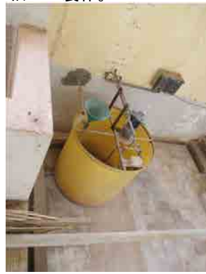
Mai Nefhi浄水場 旧薬液製作室 旧Polymer製作。
