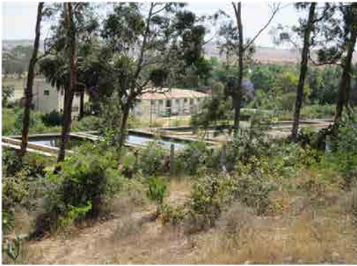
S.V浄水場 全体
