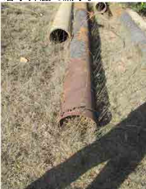
S.V浄水場 散乱する故障資材。
