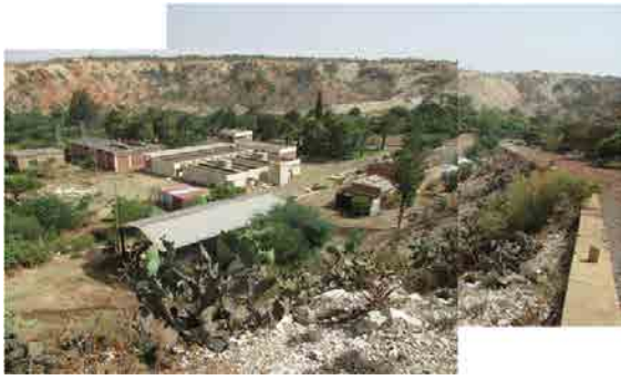
Mai Nefhi浄水場 全体
