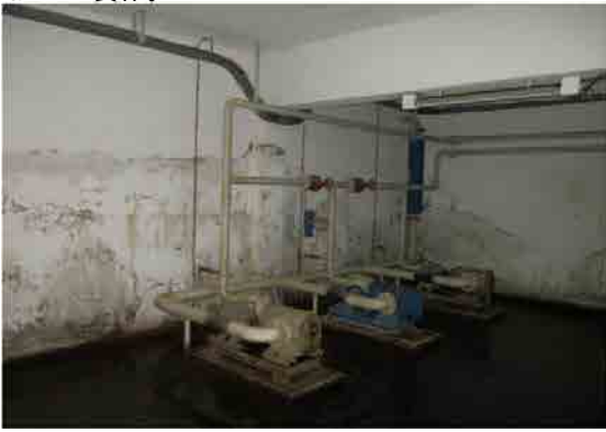
Mai Nefhi浄水場 地下機械室 パルセーターが稼働していないため十分な凝集沈殿がされていない。
