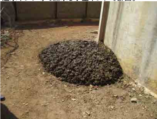
Monopolio配水池 配水池に溜まった泥。
