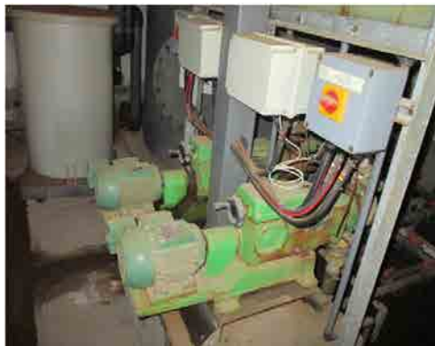
Toker浄水場 次亜塩素酸生成液のケミカルポンプ
