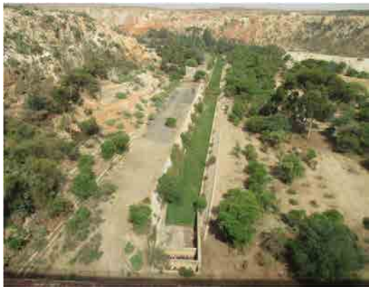
Mai Nefhiダム 排泥水路
