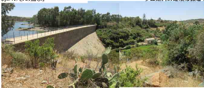
Mai Serwaダム 重力式コンクリートダム全体 左にあるのは導水ポンプ場。
