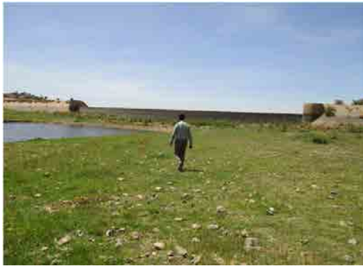
Adi Shekaダム ダム湖内 ダム湖内の堆積土が多い。
