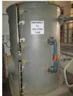
Toker浄水場 次亜塩素粉末から製作するタンク
