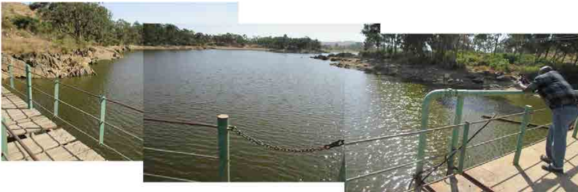
S.Vダム 重力式コンクリートダム全体 2015年4月時点で十分な水量があるように見えるが堆積土多く水位はない。
