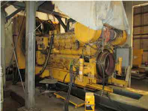
Toker導水エンジンポンプ CATでメンテ中。
