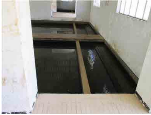
S.V浄水場 調整池
