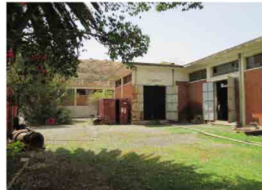
Mai Nefhi浄水場 送水ポンプ施設
