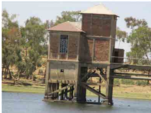
Belezaダム EECが使用している取水塔 2015年4月時点では殆ど取水できる状態ではない。
