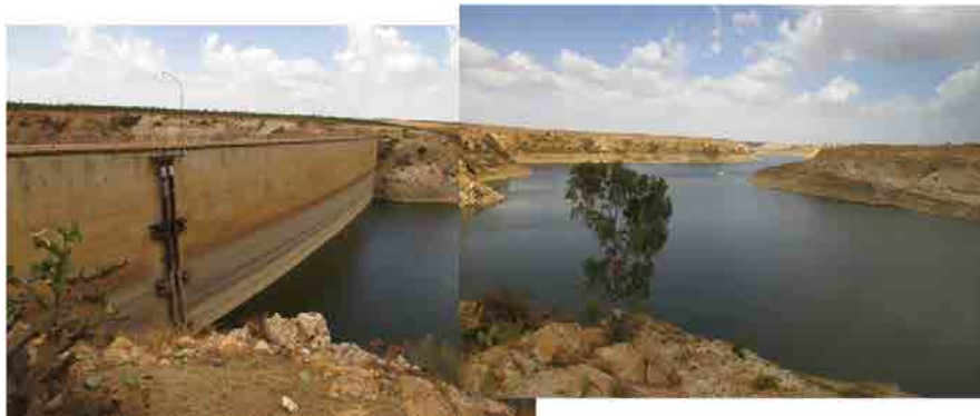
Mai Nefhiダム 重力式コンクリートダム全体
