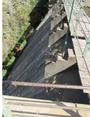
S.Vダム 重力式コンクリートダム全体 2015年4月時点で十分な水量があるように見えるが堆積土多く水位はない。
