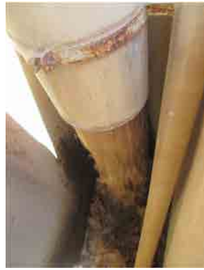
Mai Nefhi浄水場 アカズール型ろ過池 逆洗時の排水状況。
