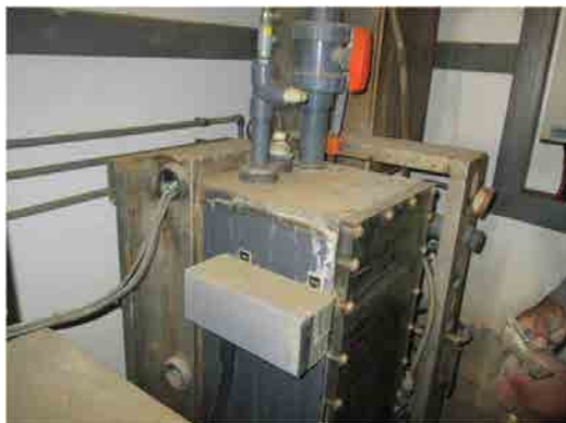
Toker浄水場 次亜塩素酸生成器
