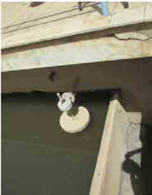
Mai Nefhi浄水場 アカズール型ろ過池 パーシャリゼーションボックスの故障。
