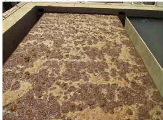
Mai Nefhi浄水場 アカズール型ろ過池 逆洗方法は、水と空気で同時に7分洗浄し、水のみで8分
