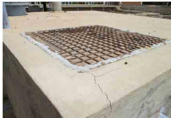
Mai Nefhi浄水場 パルセーター型凝集沈殿池 マンホール蓋が腐食。
