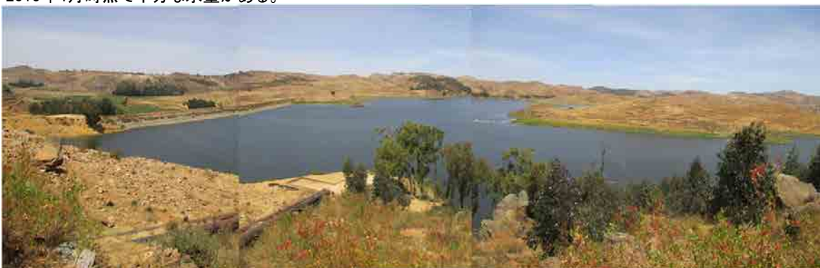
Adi Shekaダム アースダム全体
