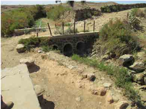
Ela Nahib (Adi Nefas)ダム 洪水吐 洪水吐き兼Valle Gnechiダムまでの旧水路
