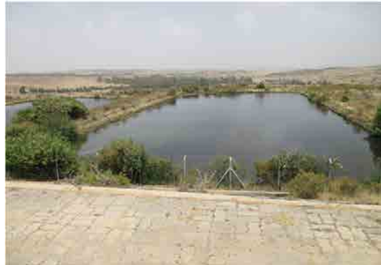
Toker浄水場 排水処分池
