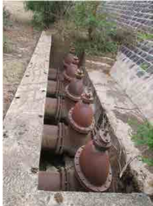
Mai Nefhiダム 排泥管 使用できるのかは不明。
