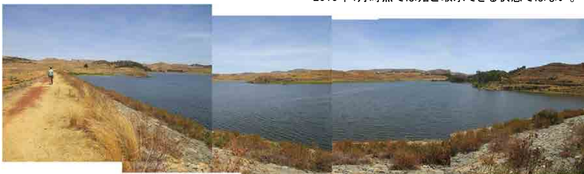
Adi Shekaダム アースダム全体 2015年4月時点で十分な水量がある。
