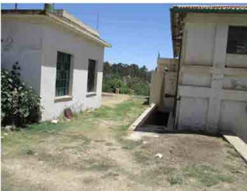
S.V浄水場 発電機室
