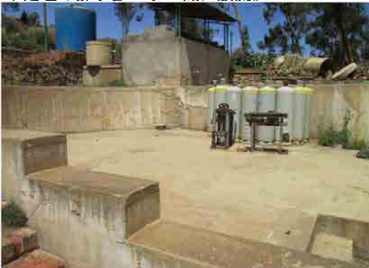
S.V浄水場 旧薬液製造施設
