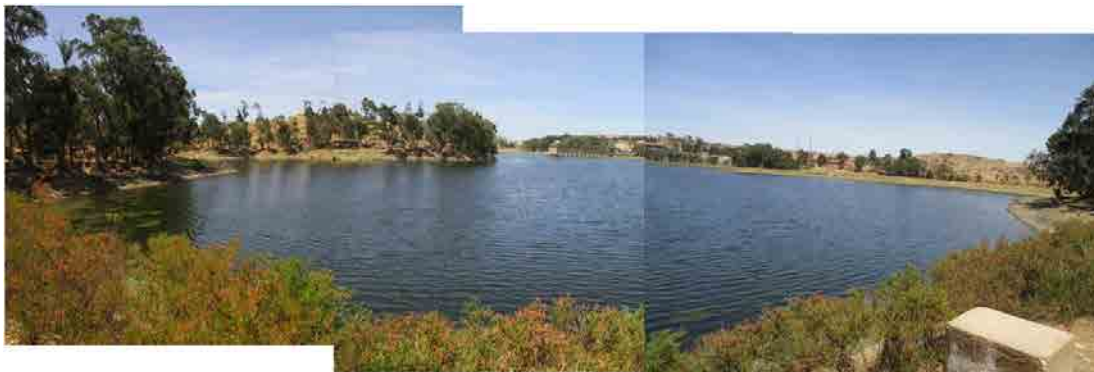
Belezaダム 重力式コンクリートダム全体 2015年4月時点で水がある様に思えるが堤体の部分のみである。
