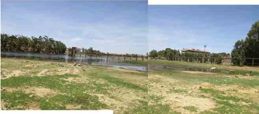
Belezaダム ダム湖全体 EECが使用している取水塔と火力発電所。ダム湖内の堆積土が多い。
