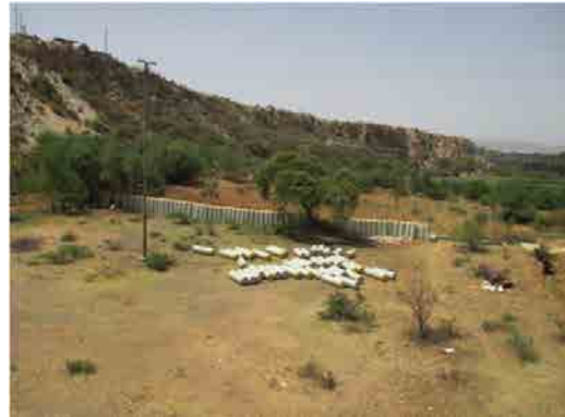
Mai Nefhi浄水場 散乱する塩素ガス。
