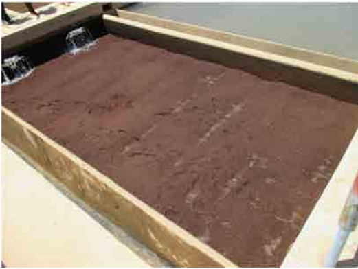
Mai Nefhi浄水場 アカズール型ろ過池 逆洗後のろ床に状況。
