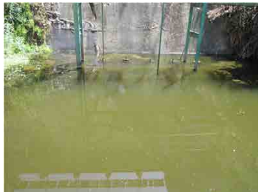
S.Vダム 排泥管 5つあるがどれも泥が詰り未稼働。
