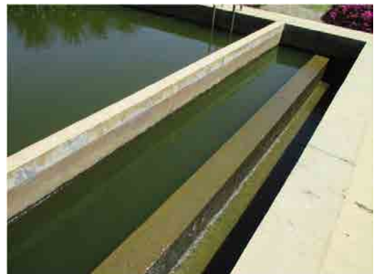
S.V浄水場 沈殿池 出口
