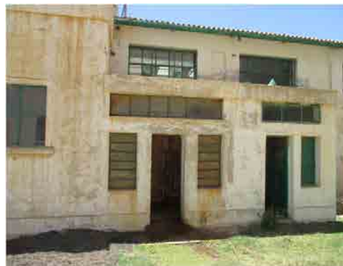
S.V浄水場 旧塩素ガス注入室
