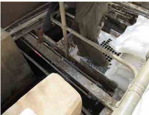
Toker浄水場 停電時はALUMを直接投入。
