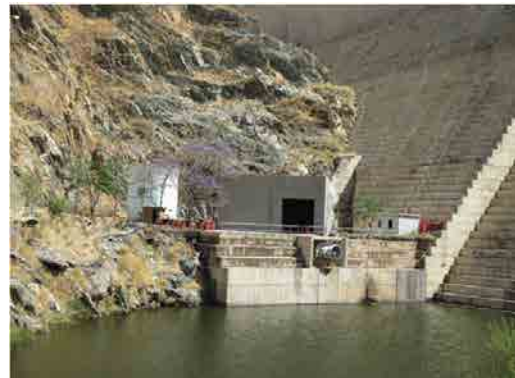
Tokerダム 導水ポンプ場と放水吐き
