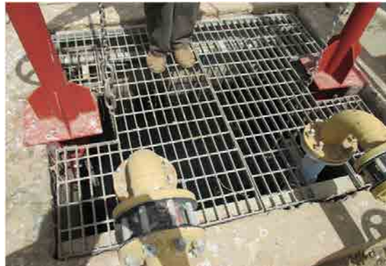
Toker浄水場 排水池の水中ポンプ
