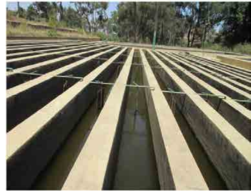
S.V浄水場 フロック形成池のデフレクター
