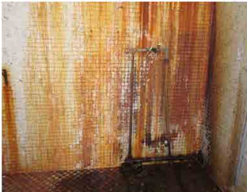
S.V浄水場 旧塩素ガス注入室
