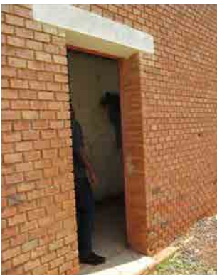
Mai Nefhi浄水場 旧塩素ガス室
