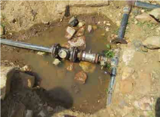
Mai Nefhi給水所 故障したメータと漏水。
