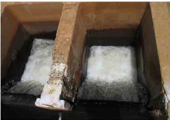
Mai Nefhi浄水場 着水井
