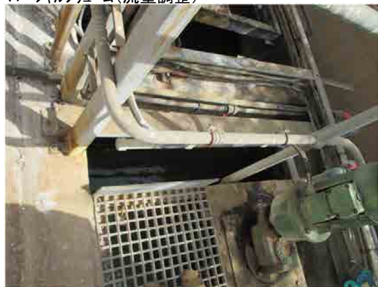
Toker浄水場 攪拌池 No.1 ALUM注入地点
