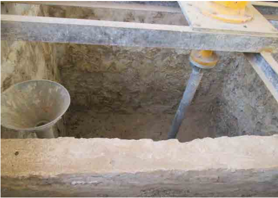
Mai Nefhi浄水場 旧薬液製作室 旧ALUM製作。
