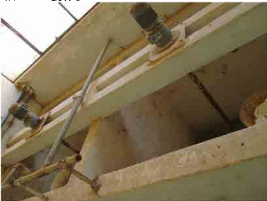
Mai Nefhi浄水場 旧薬液製作室 旧Lime製作。
