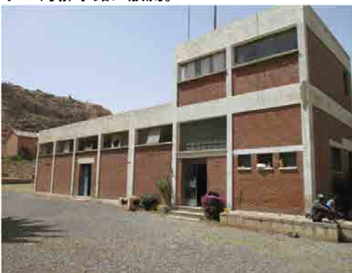
Mai Nefhi浄水場 管理室、旧薬液製作室、旧塩素室、機械
