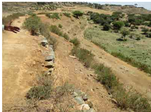
Valle Gneccchiダム 堤体の下流のり面
