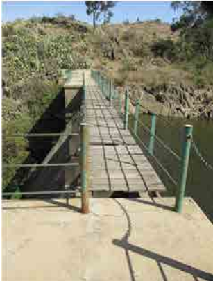
S.Vダム 堤体内洪水吐き
