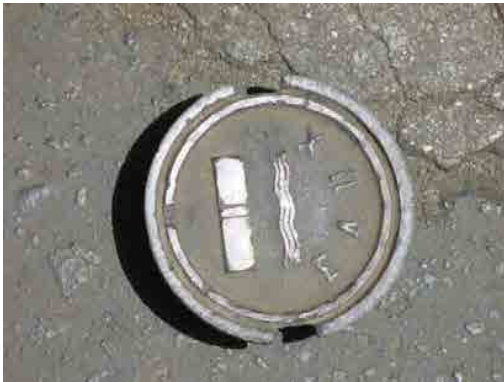
市内配水管 バルブボックス。
