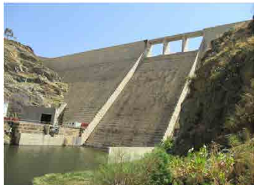
Tokerダム 堤体下流側 堤体内洪水吐き
