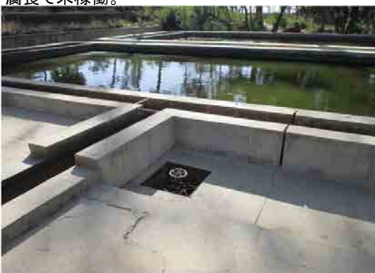
S.V浄水場 沈殿池
