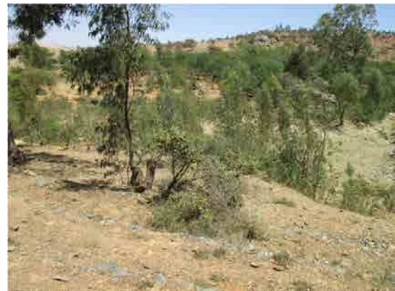
Mai Serwaダム 洪水吐き 仮設洪水吐きが現在も使用されている。
