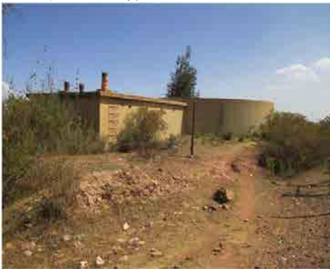
S.V浄水場 逆洗タンク
