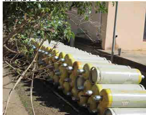
Toker浄水場 積み重ねられた塩素ガス。
