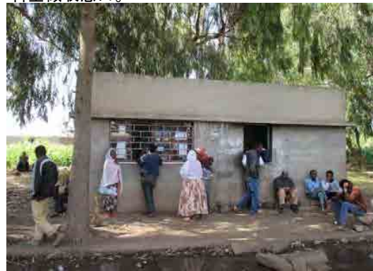
Expo給水所 AWSD給水販売所。
