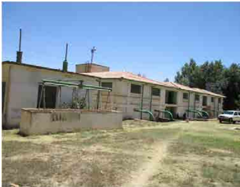
S.V浄水場 ろ過池と浄水池の建屋
