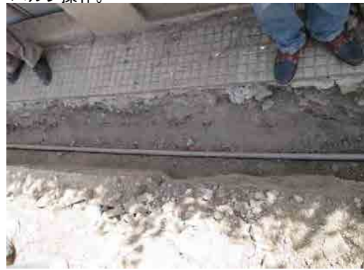
市内給水管 給水管詰り解消工事。
