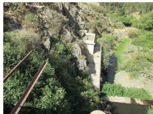
S.Vダム 旧取水ポンプ場 排泥管から取水していた。
