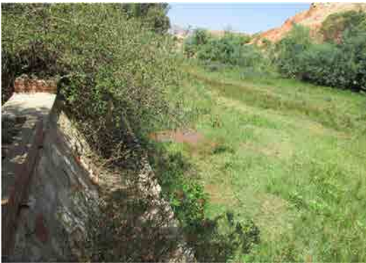
Mai Nefhi浄水場 排水 ダム汚排水路に放流。
