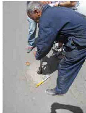
市内配水管 バルブ操作。
