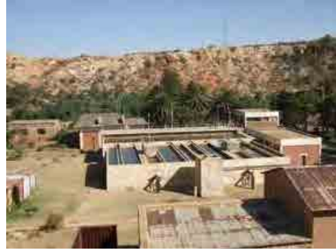
Mai Nefhi 浄水場
