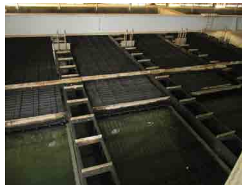
Toker 浄水場 沈殿池
