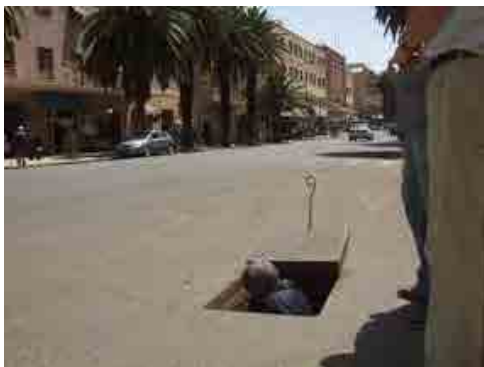
配水本管バルブピット
