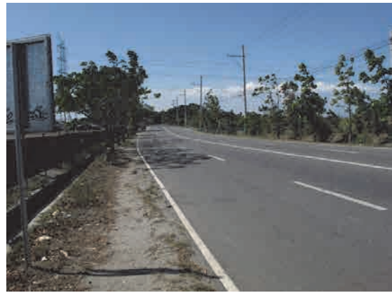
Paliparan Road 駅付近
