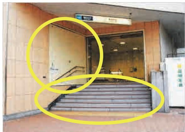
防水扉と駅施設入口の嵩上げ
