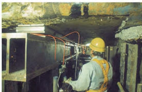
ビルの構造体と梁の間に挿入されたフラットジャッキ
