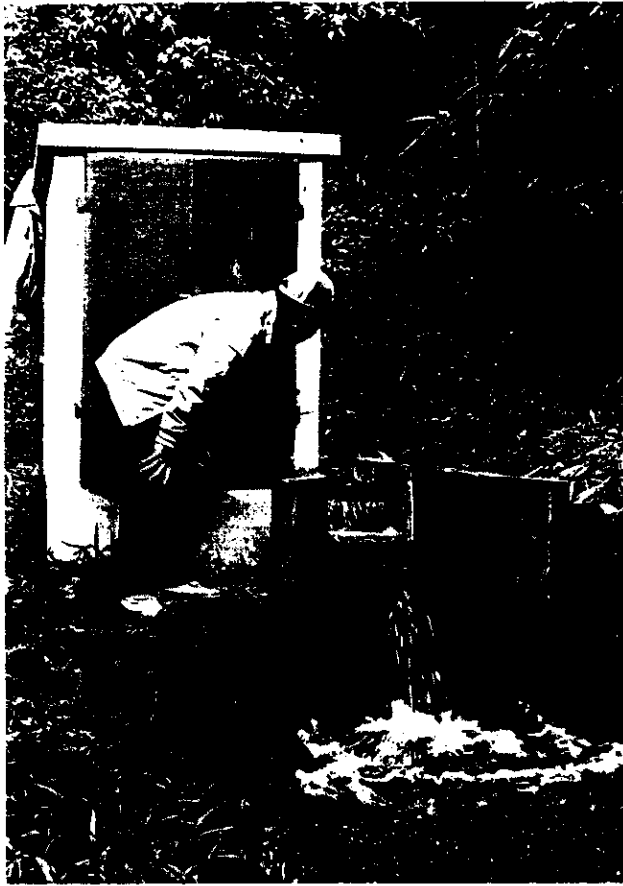
最上流(割田左岸アバット付近) の流量測定装置
