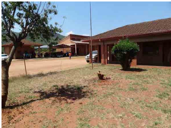
過去の無償資金協力で建設されたブロック B の コミュニティホール (IMC の定例会や契約栽培の苗配 布等、様々な用途に活用されている)
