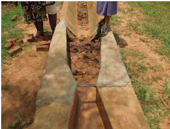
ブロック B 管理委員会 (WMC) 指導の下、 農民自身によって補修された灌漑水路
