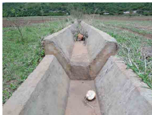
灌漑局により建設された水路
