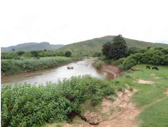
ブロック D 既設ポンプ機場からガイレンジ川上流を望む (洪水による浸食の跡が確認できる)
