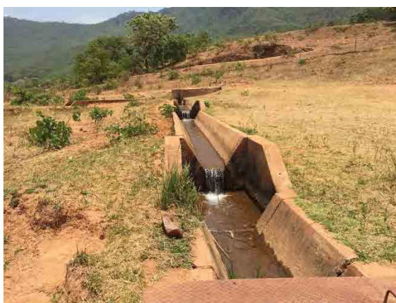
ブロック B 灌漑水路 (分水工およびファームポンド方向を望む)
