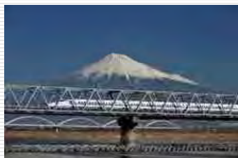
Tren Bala Tokaido (Obras Civiles)
