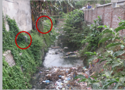
(複数のパイプが川にもき出しになっている様子)
