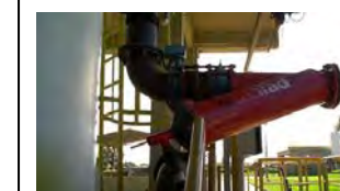
ah. Filtro de água saturada da FAD de Atuba Sul
