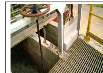
j. Padilha Sul Comporta de distribuição
