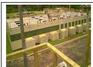
i. Guaraqueçaba Válvula de drenagem do lodo.
