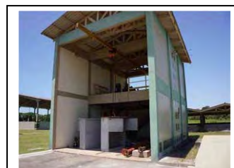
y. Guaratuba Instalação de dosador de polímero.
