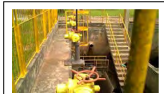
a. Comporta de entrada e gradeamento grosso de Atuba Sul
