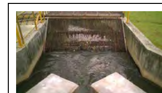
m. Gradeamento fino de Atuba Sul
