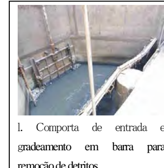
m. Gradeamento em barra para remoção de detritos
