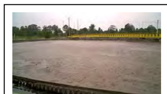
ac. Raspador de lodo do tanque de decantação final da ETE Belém
