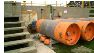
w. Equipamento de dosagem do gás cloro para desodorização do UASB em Atuba Sul
