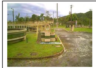
ac. Guaraqueçaba Válvula de bypass
