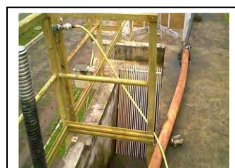
d. Guaraqueçaba Gradeamento fino
