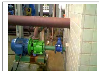
au. Matinhos Instalação de bomba FAD(para teste)
