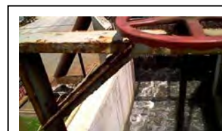
t. CIC Xisto Comporta de separação (do lado jusante)
