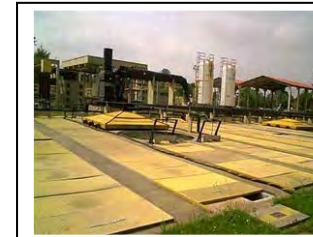
aa. Santa Quitéria Tanque de armazenamento de cloreto férrico
