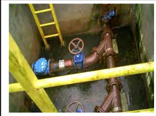
ae. Guaraqueçaba Tubulação de saída de lodo da bomba de recirculação .
