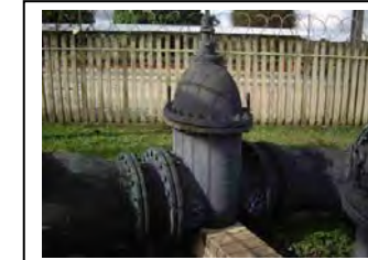
m. Válvula de retenção
