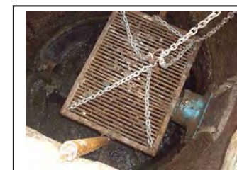
e. Tela de remoção de detritos.
