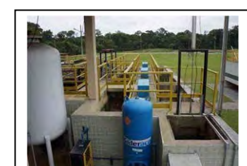
bk. Agitador do tanque de mistura de produto químico e tanque de ar de Pontal do Paraná
