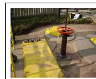
d. Plataforma de abertura e fechamento
