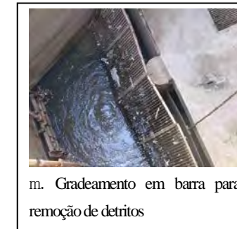
l. Comporta de entrada e gradeamento em barra para remoção de detritos
