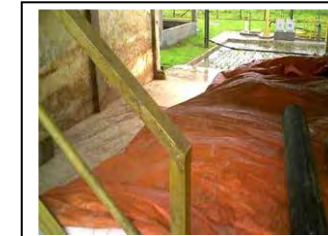
t. Guaraqueçaba Bomba de inserção de lodo no desaguador centrífugo.
