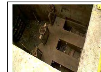
f. Padilha Sul Gradeamento grosso em barra
