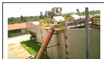
o. CIC Xisto Removedor automático de detritos e correia transportadora
