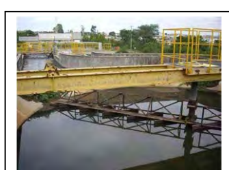
be. Removedor de lodo do tanque de desaneração de Atuba Sul
