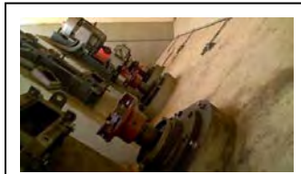
d. Tractionador elétrico e redutor de velocidade do tracionador da bomba de recalque de Atuba Sul
