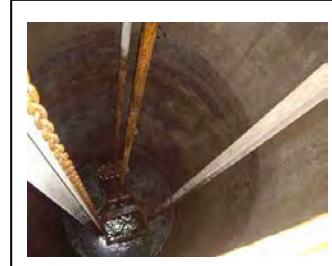
c. Cesto para remoção de detritos, válvula de separação.
