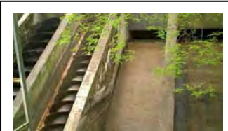
d. Bomba elevatória da ETE Belém
