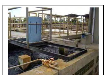
bi. Agitador rápido da FAD de Atuba Sul
