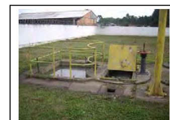
d. Instalação de bomba elevatória.
