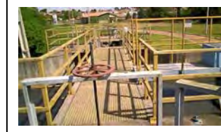
s. Fazenda Rio Grande Comporta de separação do desanador. (Comporta dos fundos)
