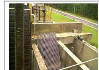
d. Gradeamento de barras finas de Pontal do Paraná
