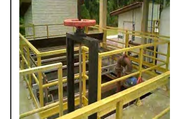
aw. Comporta de entrada da FAD de Pontal do Paraná.
