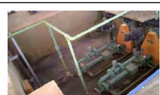
w. Fazenda Rio Grande Bomba de inserção de lodo no desaguador centrífugo.
