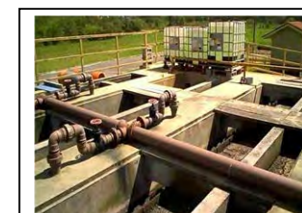
ai. Sao Jorge Dosador de peróxido de hidrogênio para desodorização do UASB
