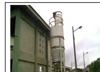
ab. Morretes Silo de armazenamento de cal hidratado da instalação de desaguamento do lodo
