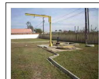
d. Instalação de bomba
