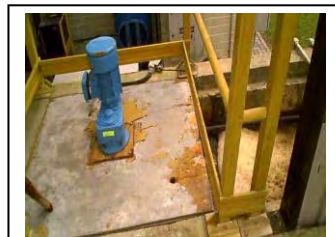
p. Agitador rápido de Pontal do Paraná
