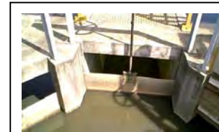
m. Fazenda Rio Grande Comporta de distribuição (do lado da jusante)
