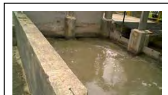
o. Comporta divisória (lado da jusante) da ETE Belém.
