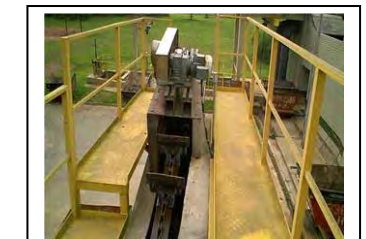
u. Padilha Sul Transportador de detritos
