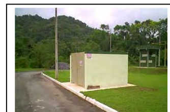
ag. Morretes Instalação de dosador de gás cloro para desinfecção
