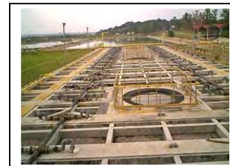
am. Padilha Sul Tubulação de gás gerado UASB
