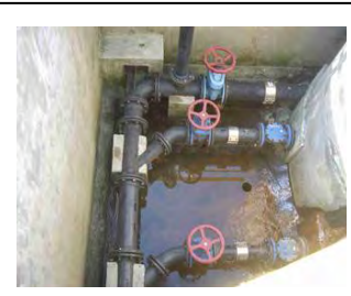
i. Tubulação de descarga, válvula de retenção e válvula de descarga (2)
