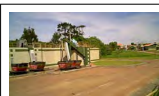
q. Fazenda Rio Grande Equipamento para transportar detritos.
