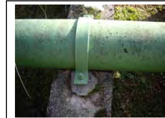
l. Suporte da tubulação de descarga.
