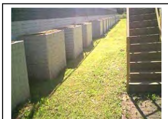
p. Matinhos Válvula de drenagem do lodo
