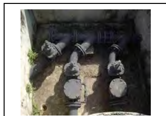
i. Válvula de retenção, válvula de descarga, tubulação de descarga (2)
