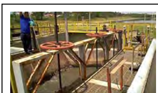
q. CIC Xisto Comporta de separação (do lado montante) e gradeamento fino
