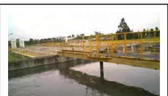
p. Removedor de lodo do tanque de desaneração de Atuba Sul
