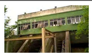
b. Painel de controle da comporta de captação ETE Belém
