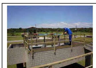
al. Guaratuba Comporta de distribuição para distribuidor.
