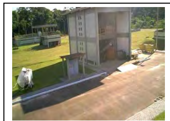
aj. Matinhos Desaguador centrífugo de lodo
