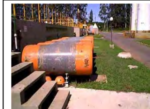
z. Equipamento de dosagem do gás cloro para desodorização da FAD de Atuba Sul
