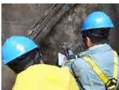
Perfurando a parede lateral
