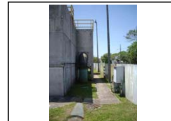
k. Praia de Leste Painel de controle da bomba de amostragem da água bruta
