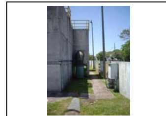
i. Praia de Leste Aqueduto de interior da ETA
