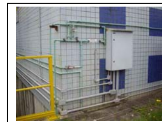
an. Painel de controle da bomba para amostragem de Iraí
