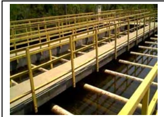
o. Saiguaçu Cuba de captação de água do tanque de decantação
