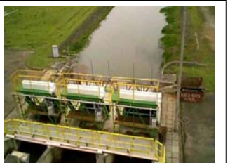
d. Removedor automático de detritos de Irai
