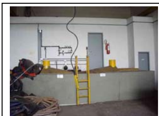
ek. Dosador de carvão ativado em pó do tipo umidificado em Irai
