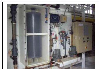
bl. Reator para geração de dióxido de cloro em Irai
