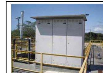
m. Praia de Leste Painel de controle do Misturador lento do tanque de floculação
