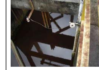
ce. Praia de Leste Medidor ultrassônico de nível de água de captação
