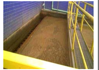
q. Raspador de espuma do lodo flotado do tanque de filtração de Irai
