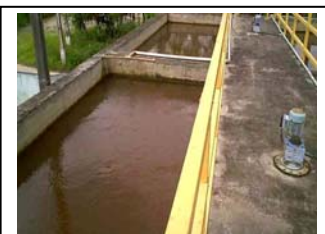
ay. Praia de Leste Tubulação de dosagem de polímero
