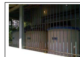
n. Morretes Tanque para dissolução de coagulante
