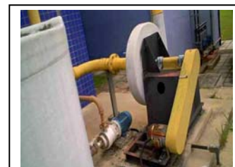
cl. Exaustor de gás neutralizado em Irai
