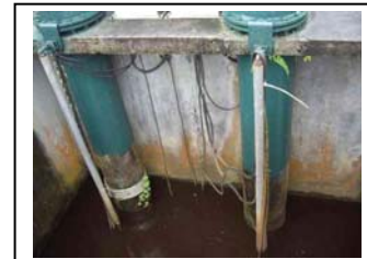
c. Praia de Leste Instalação de bomba de captação de água
