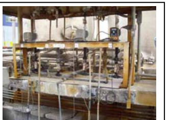
av. Bomba de dosagem de hexafluorossilicato de Irai
