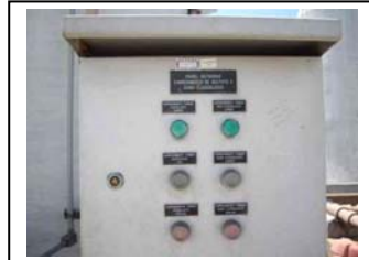
bz. Praia de Leste Painel de controle de dosador de fluoreto de hidrogênio
