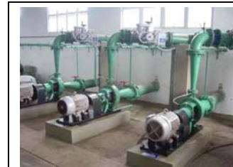
bi. Praia de Leste Bomba de transmissão de água do Sistema yy
