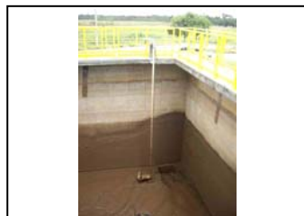
aj. Misturador submerso do tanque de água drenada de lavagem de Iraí
