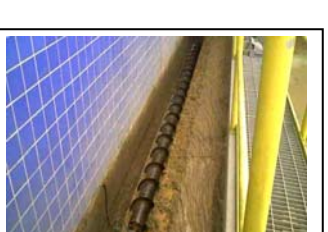
r. Transportador tipo parafuso de Irai
