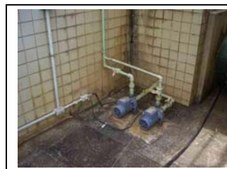
am. Bomba para amostragem de Iraí
