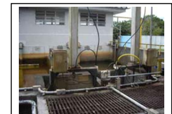
u. Praia de Leste Comporta de entrada de água drenada
