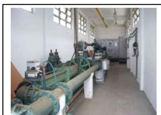
af. Praia de Leste Instalação de bomba de retorno do tanque de água drenada
