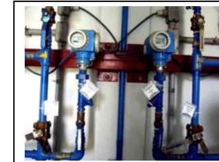
aa. Tubulação de distribuição de ar de Iraí
