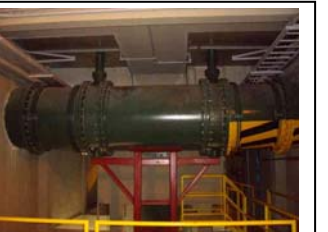
m. Válvula de entrada do tanque de floculação de Irai
