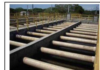
r. Praia de Leste Cuba de tanque de precipitação química
