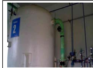
y. Tanque de mistura água-ar de Iraí
