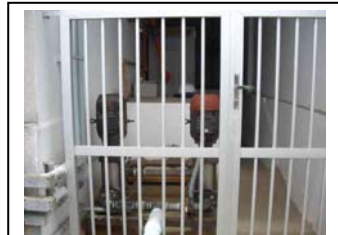
aq. Praia de Leste Instalação da bomba de alimentação
