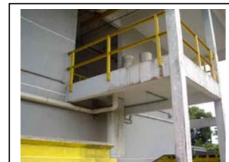
bn. Praia de Leste desaguidor centrifugo
