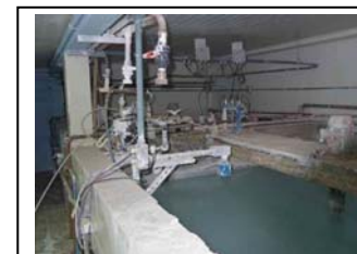
bd. Praia de Leste Tanque de dissolução de cal
