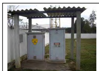
a. Cabine da entrada de força, Painel de controle da força.
