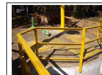
f. Instalação da bomba. (1)
