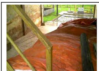
w. Guaraqueçaba Instalação para dosador de polímero
