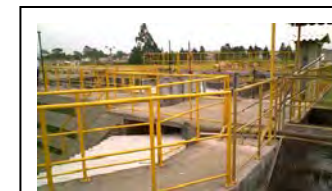
n. Comporta de distribuição de Atuba Sul (lado da jusante)
