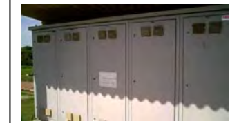
ai. Fazenda Rio Grande Painel de controle do equipamento de aeração da lagoa.
