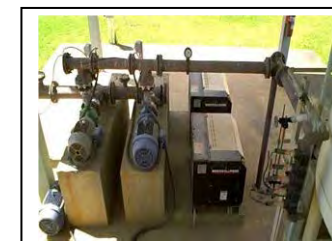
ab. Sao Jorge Tubulação de distribuição do volume de ar
