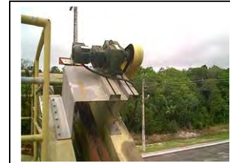
ba. Transportador de detritos de Pontal do Paraná
