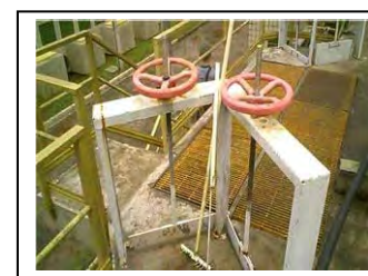
e. Guaraqueçaba Comporta de distribuição (do lado de montante)
