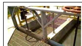
k. CIC Xisto Comporta de distribuição e gradamento grosseiro
