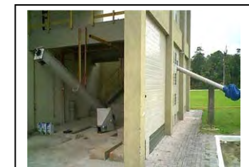
ai. Dosador de cal de Pontal do Paraná
