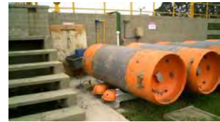
w. Equipamento de dosagem do gás cloro para desodorização do UASB em Atuba Sul
