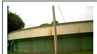
aj. Bomba de retirada de lodo do adensador de lodo da ETE Belém
