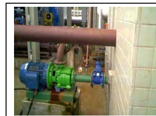
au. Matinhos Instalação de bomba FAD(para teste)
