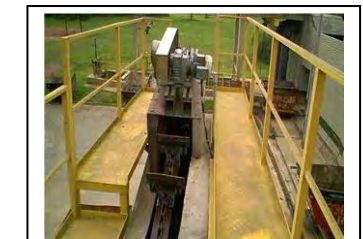
u. Padilha Sul Transportador de detritos
