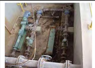
bm. Instalação da bomba de retirada do lodo da FAD de Atuba Sul
