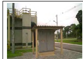
az. Painel de controle do removedor de espuma do tanque de desaneração de Pontal do Paraná
