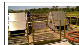
m. CIC Xisto Removedor automático de detritos e gradamento grosseiro
