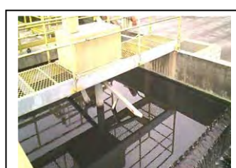
bf. Raspador de espuma do tanque de desaneração de Pontal do Paraná
