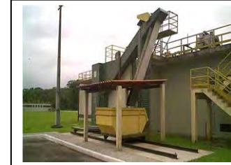
bb. Instalação de transporte de saída de detritos de Pontal do Paraná
