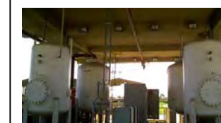
ai. Dispositivo para mistura ar-água da FAD de Atuba Sul
