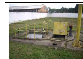
d. Instalação de bomba elevatória.
