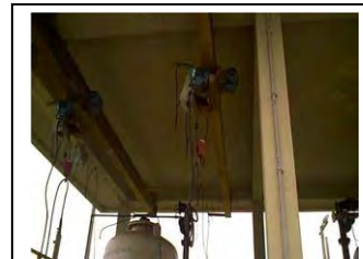
as. Talha de monotrilha da instalação de FAD de Pontal do Paraná
