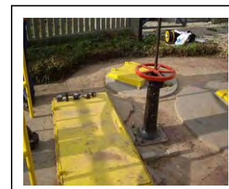
d. Plataforma de abertura e fechamento
