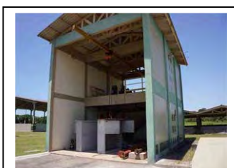
w. Guaratuba desaguador centrífugo.
