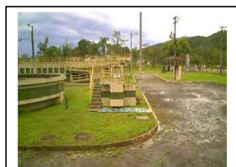
ac. Guaraqueçaba Válvula de bypass
