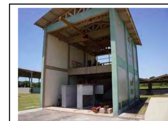
aa. Guaratuba Painel de controle de instalação para desaguamento do lodo.
