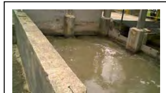
o. Comporta divisória (lado da jusante) da ETE Belém.
