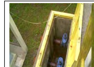
l. Guaraqueçaba Válvula by-pass.
