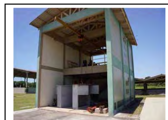
y. Guaratuba Instalação de dosador de polímero.
