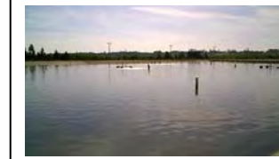
ah. Fazenda Rio Grande Equipamento de aeração da lagoa.
