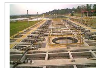
am. Padilha Sul Tubulação de gás gerado UASB
