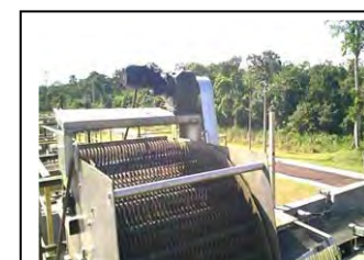
f. Matinhos Removedor automático de detritos
