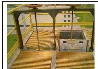
o. Comporta de distribuição de Pontal do Paraná
