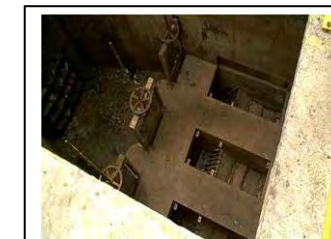
f. Padilha Sul Gradeamento grosso em barra
