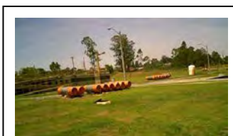
ad. CIC Xisto Instalação de dosador de gás cloro
