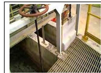
j. Padilha Sul Comporta de distribuição
