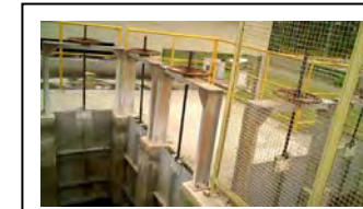
g. Comporta de distribuição de Atuba Sul (lado da montante)
