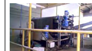
ao. Desaguador de prensa por correia de Atuba Sul
