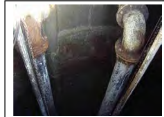
k. Bomba de retransmissão. (3)
