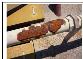
am. Guaratuba Dispositivo para queima de gás gerado na instalação de UASB
