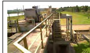
l. Fazenda Rio Grande Removedor automático de detritos e comporta de separação
