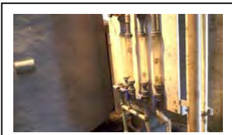
as. Dosador de polímero para desaguamento do lodo de Atuba Sul
