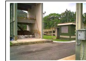
aa. Morretes Instalação de desaguamento do lodo
