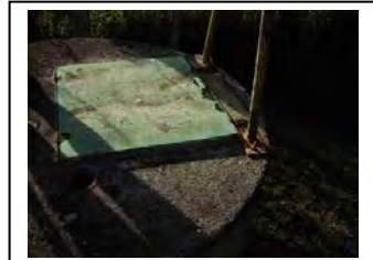
h. Tampa para vistoria da bomba.
