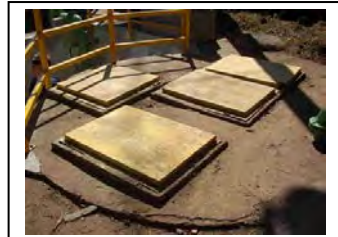
h. Instalação de bomba. (2)
