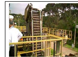
l. Padilha Sul Removedor automático de detritos
