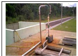
aq. Matinhos Bomba de pressão para água de cloro
