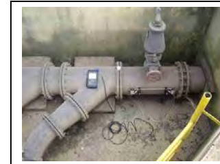
l. Válvula de ventilação de ar
