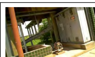
al. CIC Xisto Painel de controle de desaguador centrífugo
