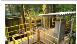
k. Removedor automático de detritos e seu painel de controle da ETE Belém
