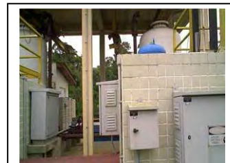
q. Painel de controle do agitador rápido de Pontal do Paraná
