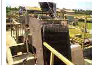
f. Guaratuba Removedor automático de detritos
