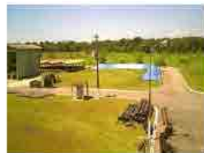
a. Guaratuba Transformador instalado em poste
