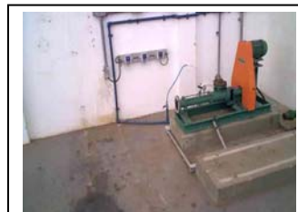
bh. Saiguaçu Bomba de condução de lama
