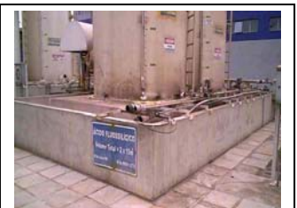
au. Bomba de fornecimento do tanque de hexafluorossilicato de hidrogênio de Irai
