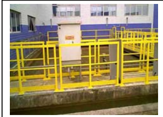
o. Painel de controle do misturador lento do tanque de floculação de Iraí
