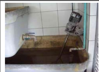
y. Guaraqueçaba Tanque para dissolução e misturador
