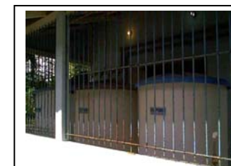
n. Morretes Tanque para dissolução de coagulante
