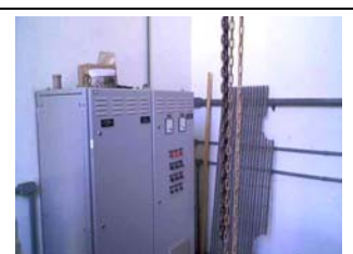
i. Morretes Painel de controle de água saturada do filtro e de
