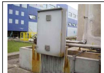
ax. Painel de controle do dosador de hexafluorossilicato de hidrogênio de Irai
