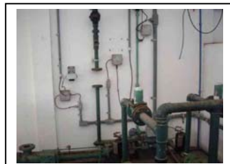
bl. Praia de Leste Instalação de bomba de inserção de lodo
