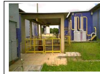
dj. Bomba para drenagem de água dentro de Irai
