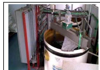
bw. Tanque para dissolução de ácido polifosfórico em Irai
