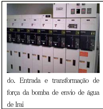
dn. Painel de controle da entrada e de transformação de força de Irai
