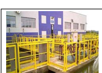
p. Comporta de entrada do tanque de filtração de Iraí
