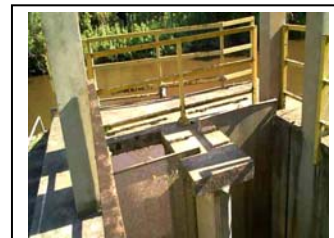
bp. Saiguaçu Gradiamento da entrada do tanque de água bruta
