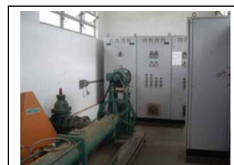
ag. Praia de Leste Pannel de controle do tanque de água drenada
