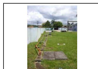
an. Praia de Leste Tubulação de dosagem de polialumínio
