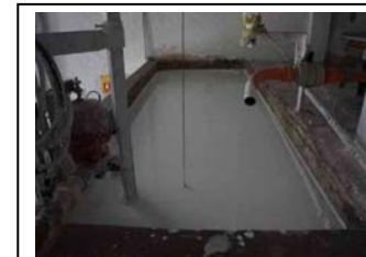
br. Tanque para dissolução de cal em Irai
