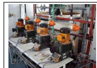
bx. Bomba para dosagem de ácido polifosfórico em Irai
