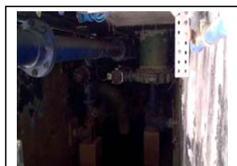
ac. Praia de Leste Válvula de limpeza por ar do tanque de filtração
