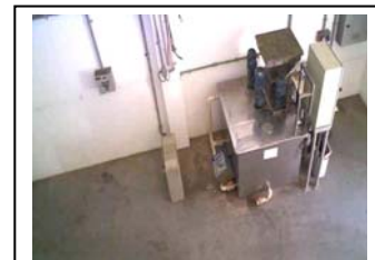
bk. Saiguaçu Tanque de dissolução de polímero
