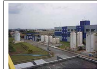
ei. Equipamentos para dosagem de produtos químicos de Irai
