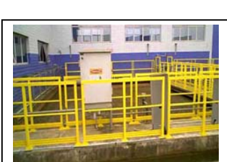
s. Painel de controle do removedor de espuma do lodo flotado de Iraí
