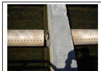
bs. Praia de Leste Cuba do tanque de sedimentação química
