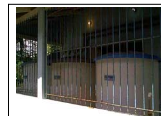
t. Morretes Tanque para dissolução de fluoreto de silicato de sódio
