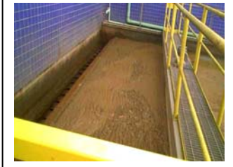
q. Raspador de espuma do lodo flotado do tanque de filtração de Iraí
