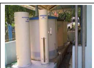
q. Morretes Tanque para dissolução de hipoclorito de cálcio
