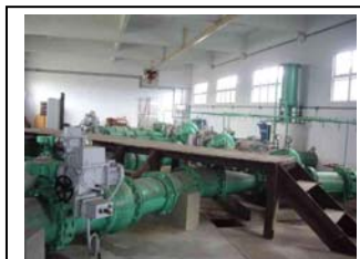
bh. Praia de Leste Instalação de bomba envio de água de sistema xx
