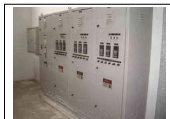
bv. Painel de controle do dosador de cal em Irai
