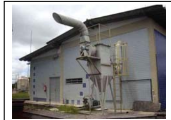
ef. Removedor de sujeiras do dosador de cal de Irai
