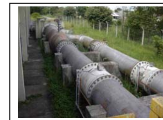
cz. Medidor de vazão do envio de água de Irai
