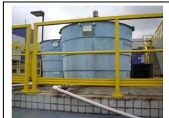
bn. Tanque para dissolução de polímero em pó em Irai
