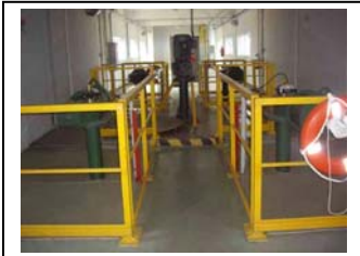
k. Misturador rápido do poço de chegada de água de Iraí
