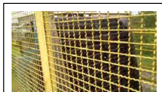
h. Removedor de detritos de Atuba Sul
