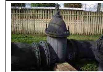
m. Válvula de retenção
