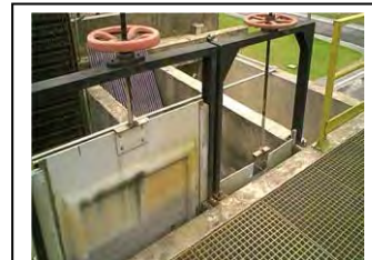
c. Comporta de distribuição de Pontal do Paraná
