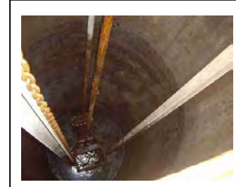
c. Cesto para remoção de detritos, válvula de separação.
