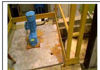
p. Agitador rápido de Pontal do Paraná
