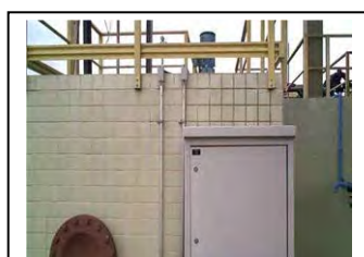
v. Matinhos Painel de controle de misturador rápido
