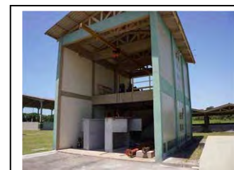
aa. Guaratuba Painel de controle de instalação para desaguamento do lodo.
