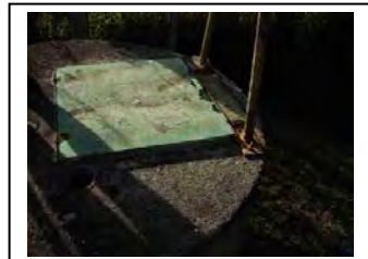
h. Tampa para vistoria da bomba.
