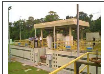
aq. Dispositivo de mistura água-ar da instalação FAD de Pontal do Paraná
