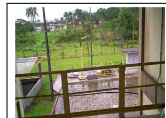
r. Guaraqueçaba Instalação de bomba de recirculação do lodo drenado.
