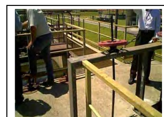
k. Guaratuba Comporta de separação (do lado de jusante)
