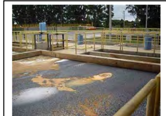
bl. Comporta de entrada do tanque da instalação da FAD de Atuba Sul
