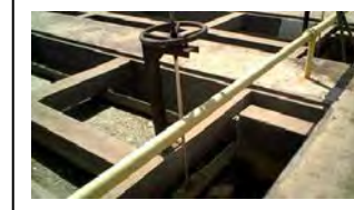
t. Fazenda Rio Grande Comporta de drenagem do lodo do tanque de reação do UASB
