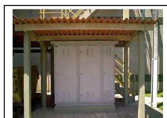
h. Guaratuba Painei de controle de removedor automático
