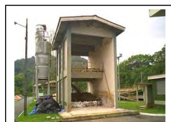
x. Morretes Instalação de desaguamento do lodo
