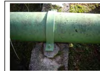
l. Suporte da tubulação de descarga.
