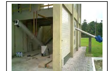
ai. Dosador de cal de Pontal do Paraná
