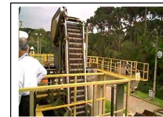
l. Padilha Sul Removedor automático de detritos
