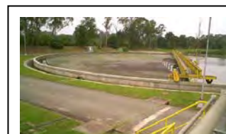
ab. Raspador de lodo tanque de decantação final da ETE Belém.
