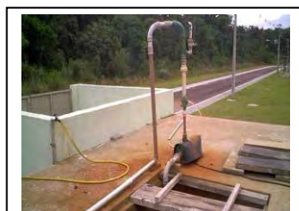
aq. Matinhos Bomba de pressão para água de cloro
