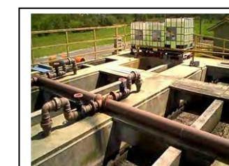
ai. Sao Jorge Dosador de peróxido de hidrogênio para desodorização do UASB
