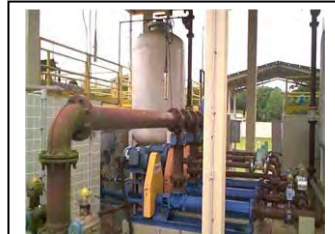
w. Tanque de mistura água-ar de Pontal do Paraná
