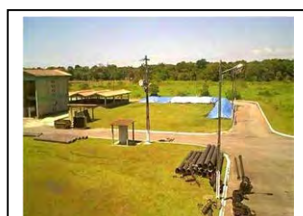
a. Guaratuba Transformador instalado em poste
