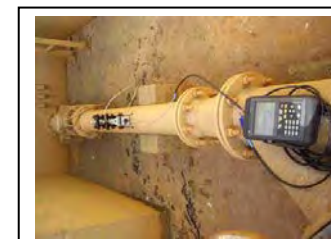
m. Medidor de fluxo eletromagnético
