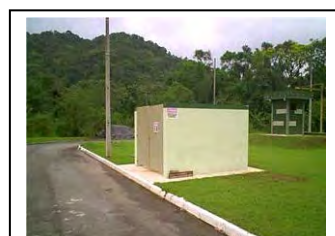
ag. Morretes Instalação de dosador de gás cloro para desinfecção
