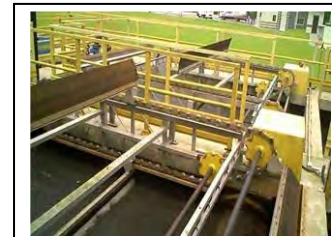
at. Removedor de espuma de Pontal do Paraná
