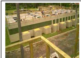
i. Guaraqueçaba Válvula de drenagem do lodo.
