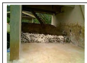
z. Morretes Instalação de desaguamento do lodo
