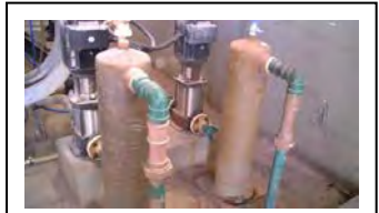
at. Bomba de lavagem da lona do desaguador de lodo por prensa a correia de Atuba Sul
