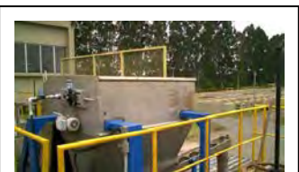
i. Removedor automático de detritos de Atuba Sul
