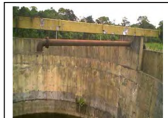
ac. Removedor de espuma de Pontal do Paraná
