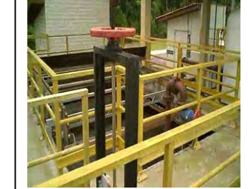
aw. Comporta de entrada da FAD de Pontal do Paraná.
