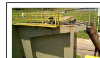
z. CIC Xisto Dispositivo de transporte de detritos
