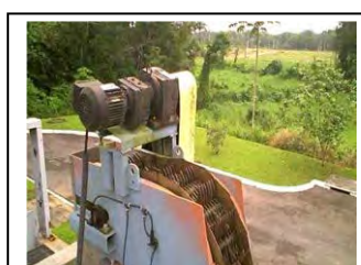
c. Morretes Removedor automático de detritos
