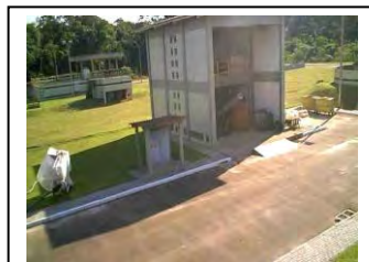
aj. Matinhos Desaguador centrífugo de lodo
