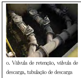
p. tubulação de descarga
