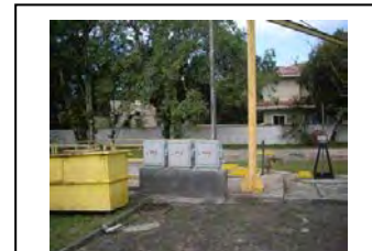
c. Instalação de bomba elevatória, caixa de junção.
