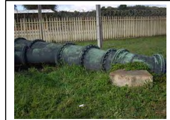
j. Tubulação de descarga (1)
