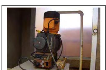
bh. Bomba dosadora de cloreto férrico (III) da FAD de Atuba Sul
