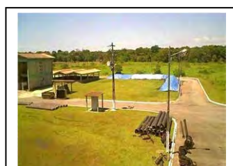
b. Guaratuba Painei de entrada de força
