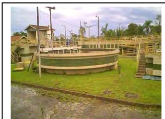
p. Guaraqueçaba Raspador de lodo
