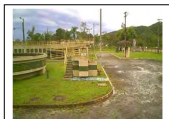
ac. Guaraqueçaba Válvula de bypass
