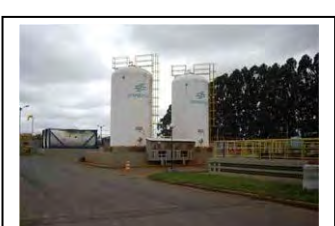
bg. Bomba dosadora de cloreto férrico (III) da FAD de Atuba Sul
