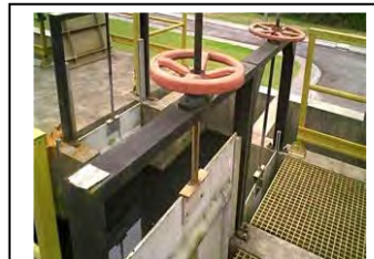
h. Comporta de separação de Pontal do Paraná (lado da montante)
