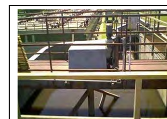
m. Guaratuba Raspador de lodo.
