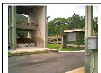
aa. Morretes Instalação de desaguamento do lodo
