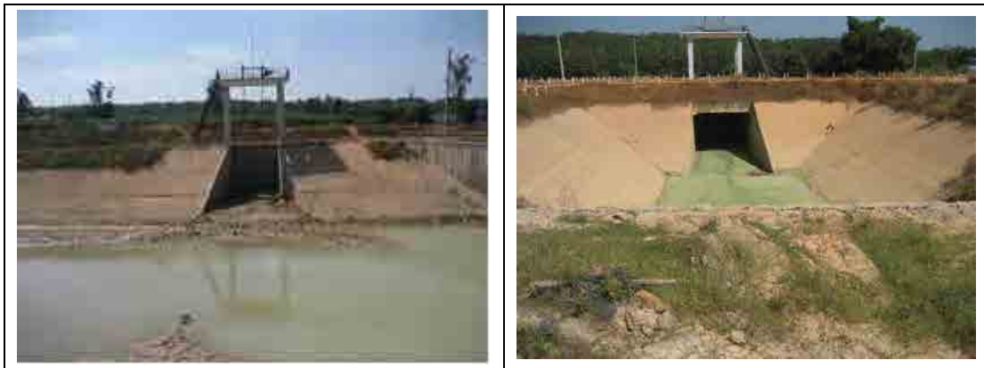
写真 5.5.1 Phuoc Hoa - Dau Tieng 導水路に建設されている取水施設
