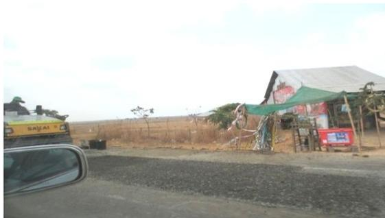
路盤材の敷均し補修状況
