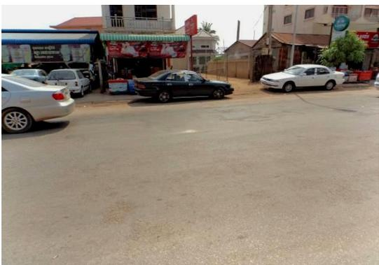
5号線の舗装の損傷状況
