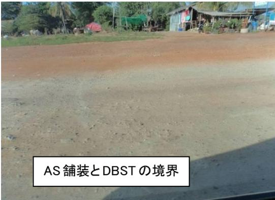
5号線のDBST全面損傷状況
