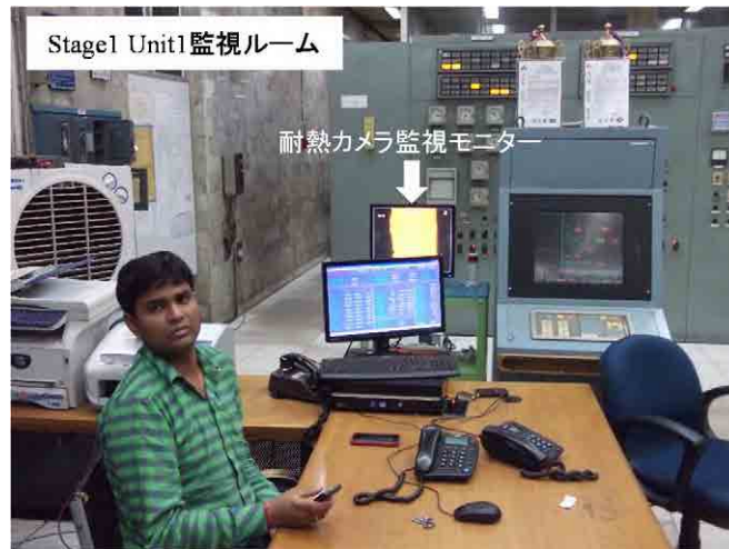
図 3-27 ボイラー運転員の横にカメラの監視モニターが設置されている
