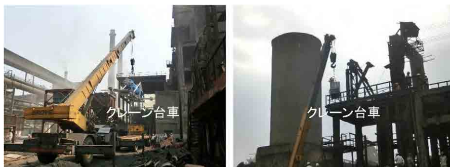
図 3-4 クレーン台車の吊り上げ作業
