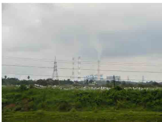
カハルガオン石炭火力発電所
