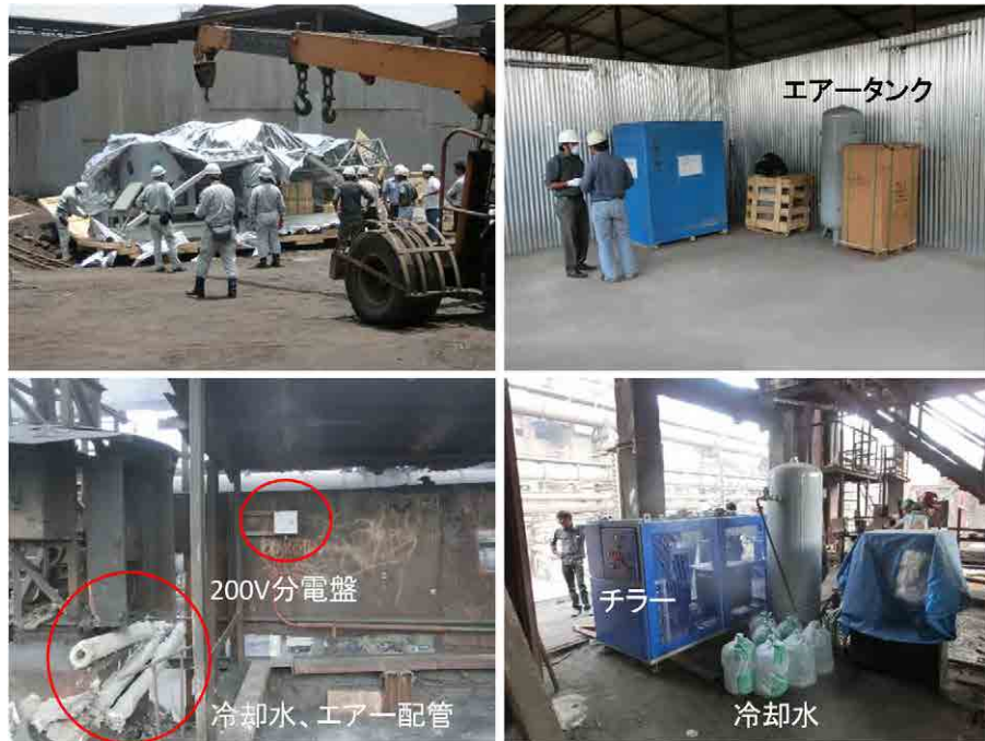
図 3-3 設置工事前の確認作業 輸出機材（上左右）、配管等工事（左下）、チラー・エアコンプレッサー（右下）
