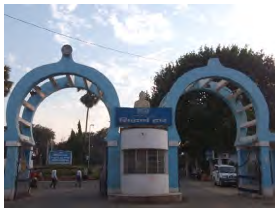
カハルガオン石炭火力発電所入館ゲート
