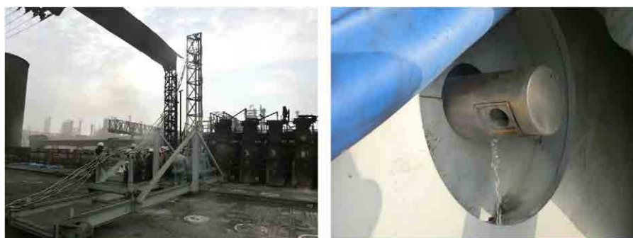
図 3-5 試験運用中のカメラの損傷（挿入前（左）、挿入後（右））
