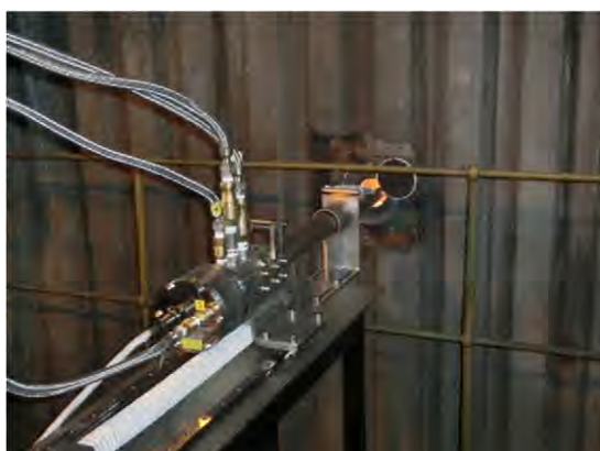
耐熱カメラ挿入 (Stage-1,Unit1,2F)
