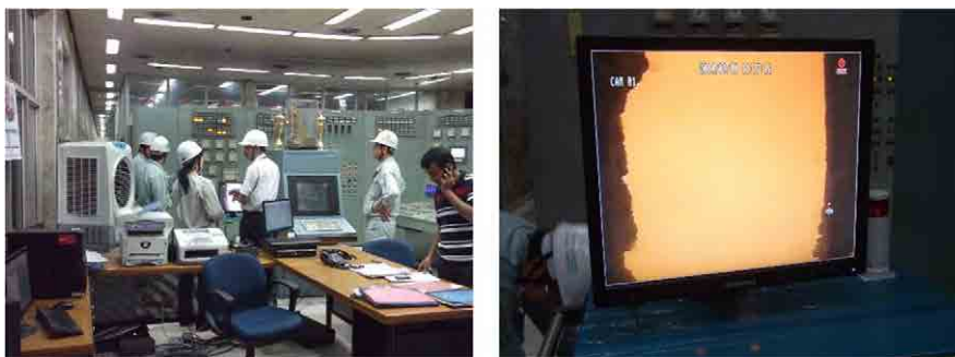
図 3-22 監視室に設置されているカメラ画像
