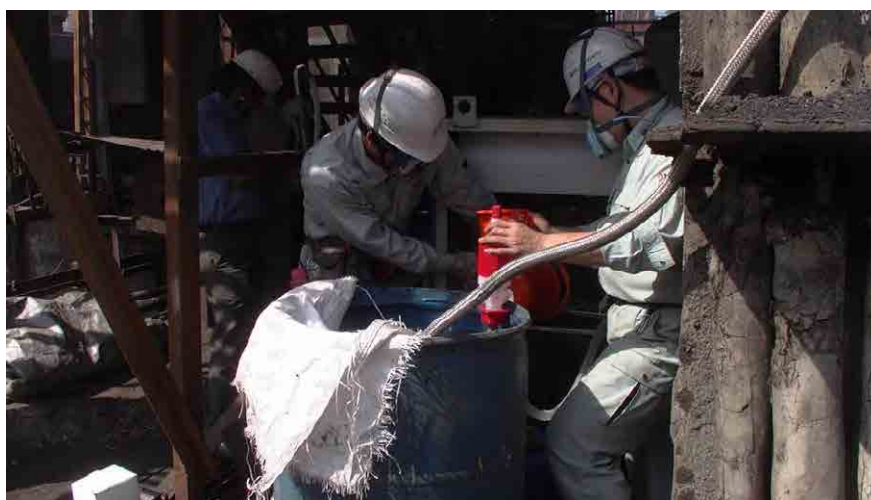
図 3-9 実際にチラー冷却水タンク容量を擬似的に増加させている模様
