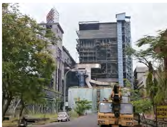
設置対象ボイラー (Stage-1、Unit1)
