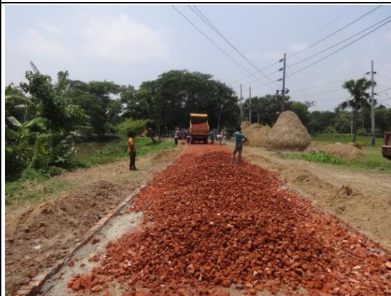
円借款 第1バッチ サブプロジェクト工事現場
