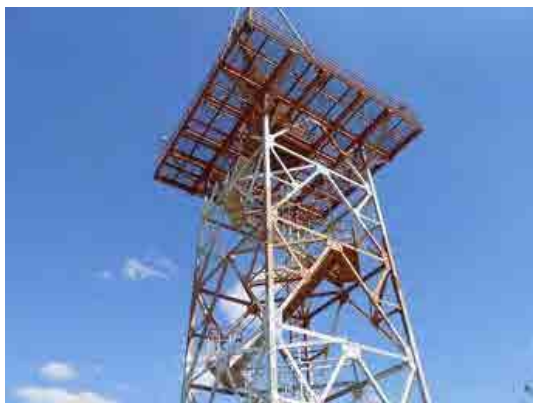
写真11 レーダータワー タワーの構造部の状態は良い
