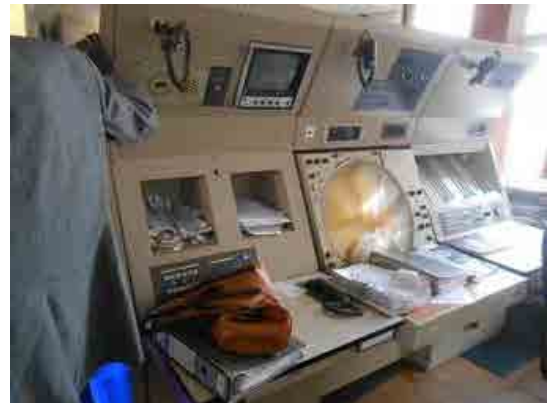
写真12 既存レーダーコンソール レーダーの故障後は使われていない
