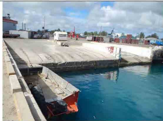
写真 1-3 : フェリー用乗降ランプ 船舶 2 隻が並行に接岸する構造。
