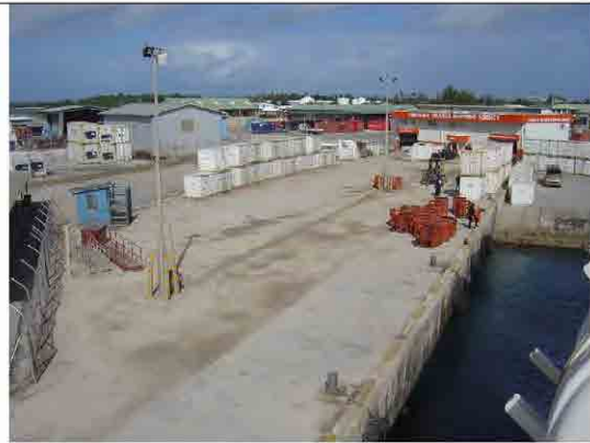
写真 1-1 : 大型国内輸送船舶用岸壁全景 クイーンサロテ埠頭内 No.3&4 岸壁 エプロン背後は未舗装
