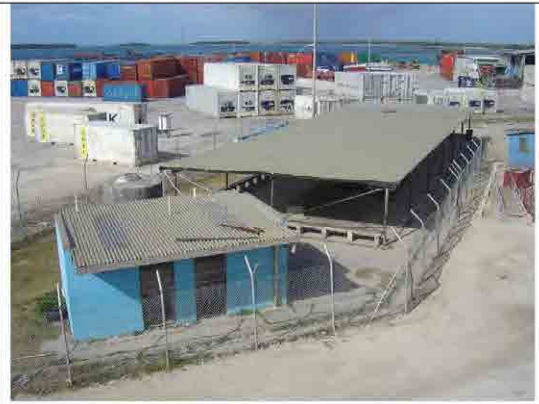
写真 1-2 : 旅客待合所及びトイレ 待合所には壁も無く吹きさらしの状態
