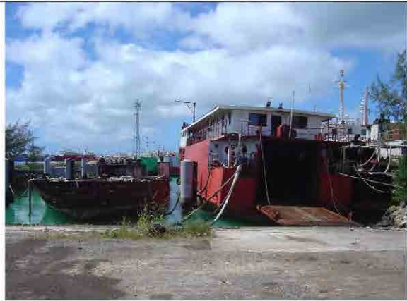
写真 2-13：ファウア埠頭西側 使用されていない老朽船が係留されている。
