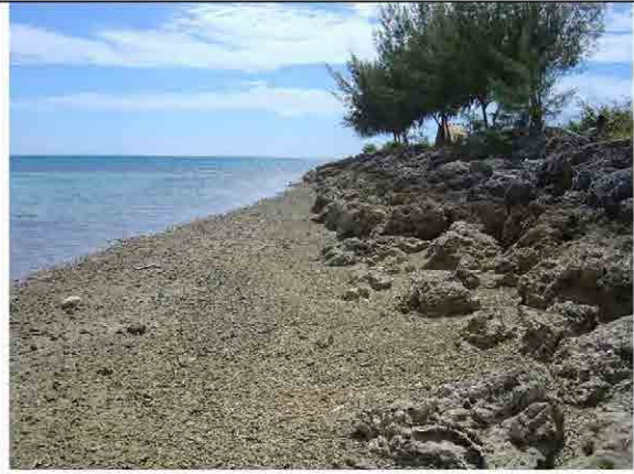
写真 2-8：ファウア埠頭西側護岸 南から北方向を撮影。
