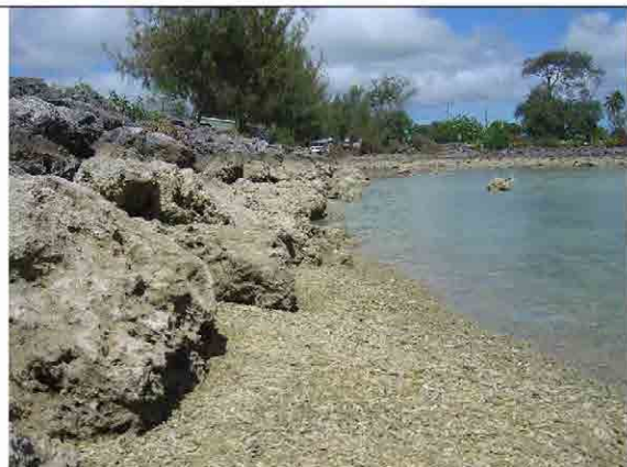
写真 2-5：ファウア埠頭西側護岸
