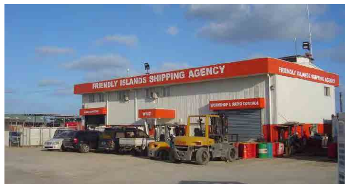
図 2-7 FISA 所有の修理棟
