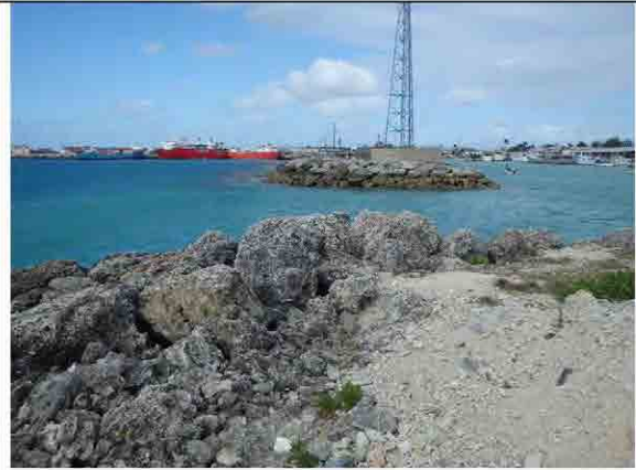
写真 2-2：ファウア埠頭港口部
