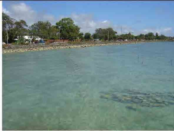
写真 2-7：ファウア埠頭西側海域 本プロジェクトの計画海域 奥にブナ道路沿いの護岸が見える。
