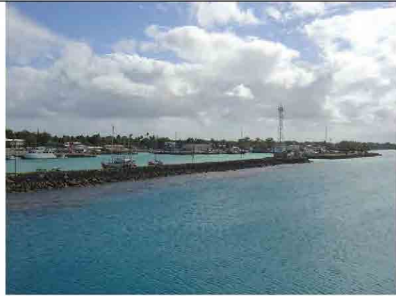
写真 2-1：ファウア埠頭全景
