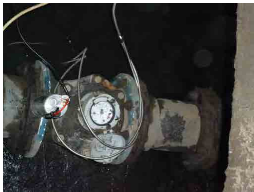
図 3-57 Bagan Deli 地区 夜間時調査 エリア流入管における AS610 漏水調査
