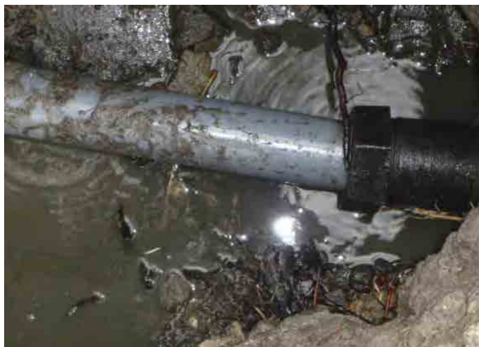
図 3-75 配管修理後：斜めに接続された管
