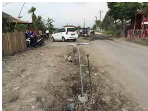
図 3-61 Sicanang 地区 (左)AS610 設置 (中央)仕切弁 (右)地下漏水
