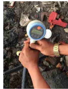
図 3-60 Sicanang 地区 水圧計設
