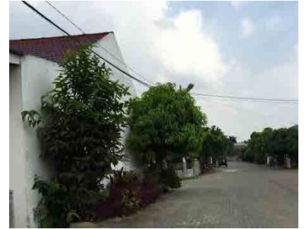
図 3-45 Villa Peruma 地区低く配線された高電圧線
