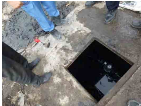
図 3-59 Sicanang 地区 AS610 設置
