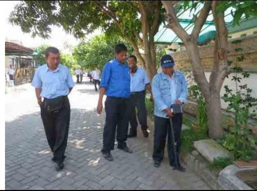
樹脂管用漏水探索・配管路探索器 PVC ロケーターD305 による漏水調査 (2014年6月9日)
