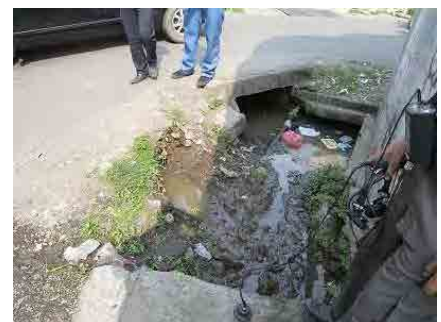
図 3-32 Pukat1 地区漏水調査
