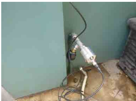
図 3-34 AS610 の宅内給水設備への設置
