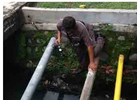
図 3-35 Amir Hamzah 地区小型軽量漏水探索による漏水調査
