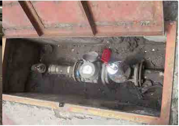
図 3-41 Bogor 地区 AS610 センサー設置
