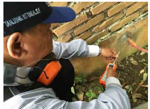
図 3-52 Waikiki 地区 ST04 による給水管漏水調査
