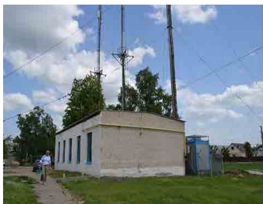
ボイラーハウス外観
