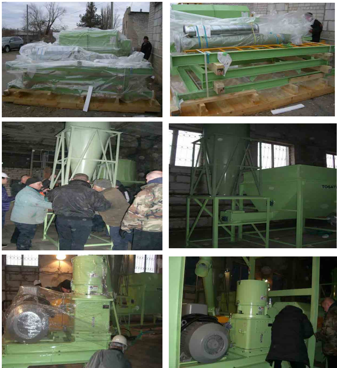
図 20 ペレット製造装置の据付・試運転・技術指導の様子（1）
