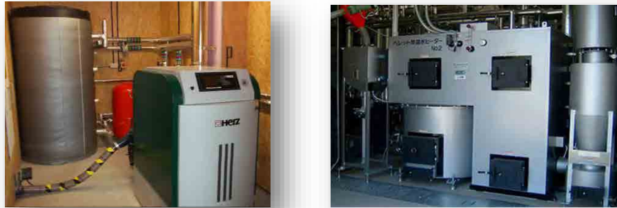
図 22 本邦製（右図）と外国製（左図）のバイオマスボイラーの外観
