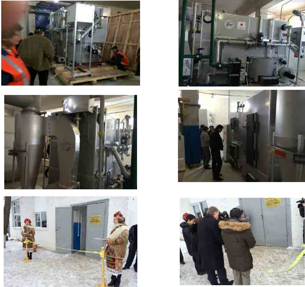
図 21 バイオマスボイラーの据付・試運転・技術指導及びセレモニー式典の様子
