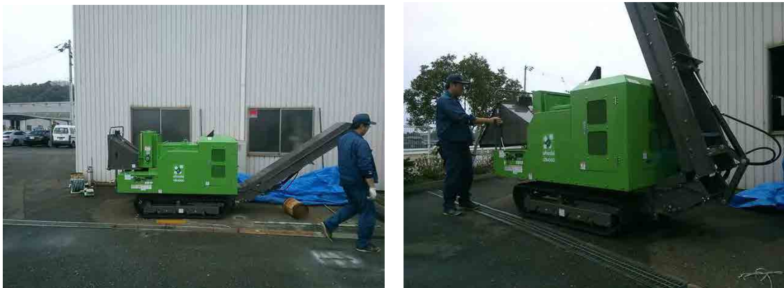
図 14 稼働試験状況 (破碎機)
