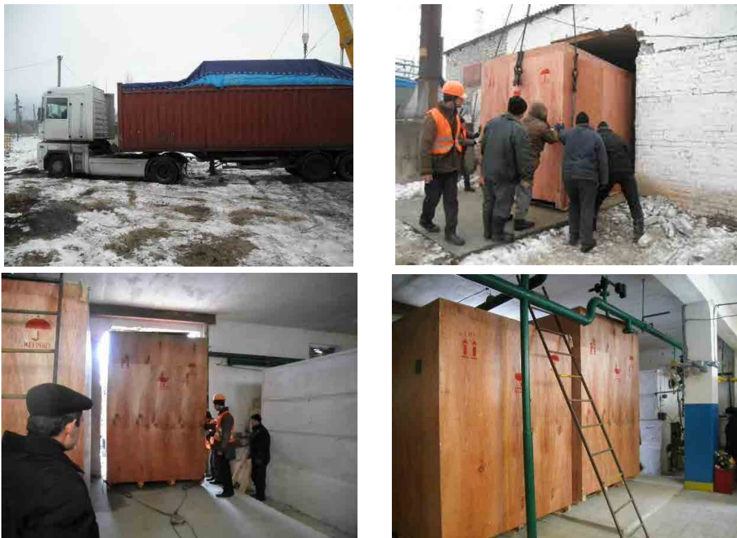
図 19 バイオマスボイラーの内陸輸送・荷降ろしの様子
