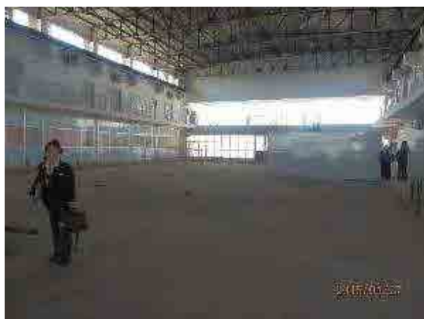
Si 還元テストプラント設置予定施設内部
