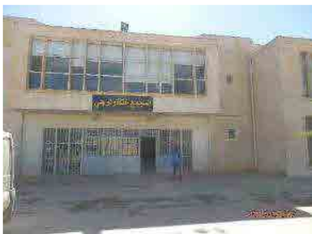
Si 還元テストプラント設置予定施設（USTO-MB）
