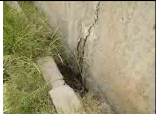
写真-6 配水池目地部
