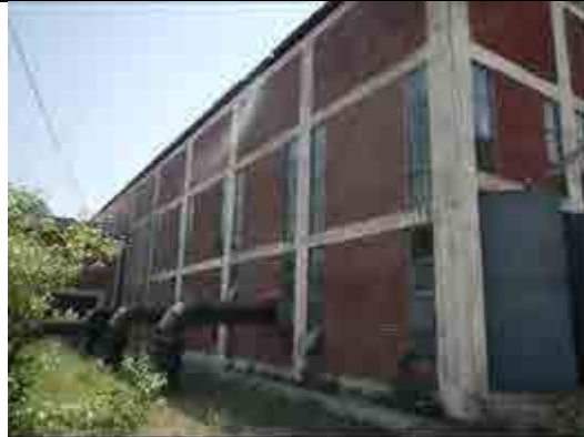
写真-3 中継ポンプ場
