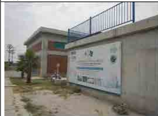
写真-11 最終配水場既存施設 日本の無償資金協力により 2012 年 6 月に完成した配水池及びポンプ棟。本プロジェクトの対象箇所である最終配水場内に位置する。
