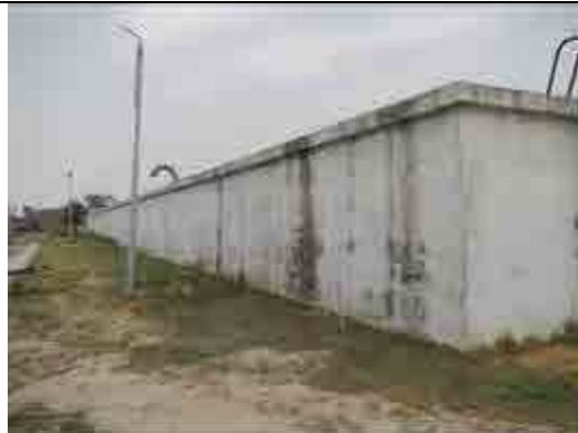
写真-5 最終配水場配水池
