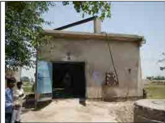
写真-1 ポンプ室
