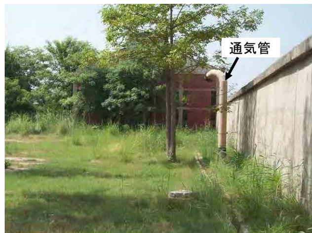
図 2.11 連絡管に設けられた通気管
