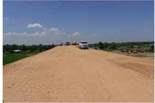
高盛土区間盛土完了 2015年4月29日
