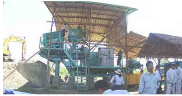
写真 2:ソイルプラント
