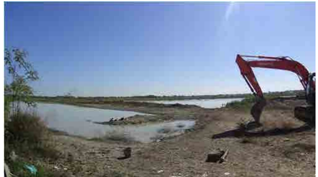
高盛土材料採取土取場の灌水状況(12月初旬)
