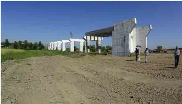
PP-2 Kyew Chan Ye Kyaw 橋取り付け高盛土道路予定地
