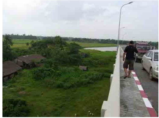
材料混合・仮置用ヤード候補地(ボガレー橋脇)
