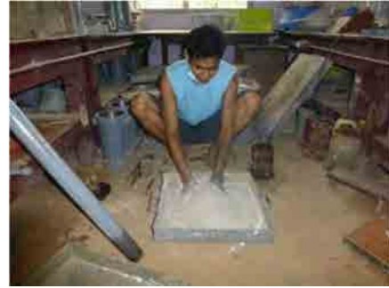
安定処理用材料練り混ぜ作業
