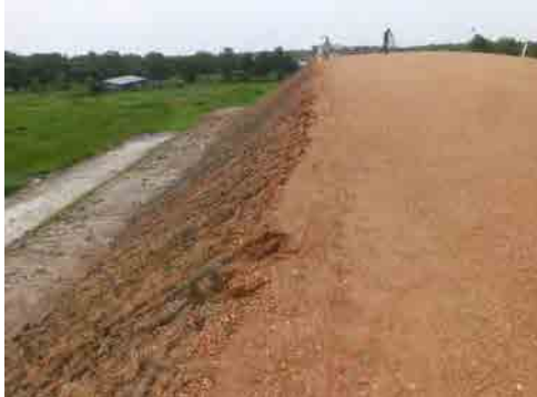
高盛土区間盛土完了 2015年4月29日
