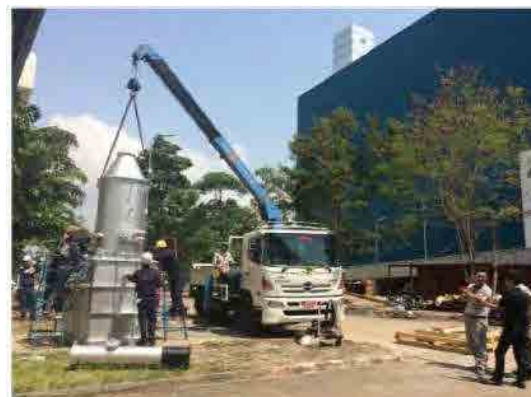
燃焼炉の据付
