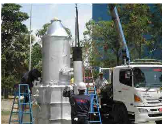
ヘルメットを被って作業安全を確保
