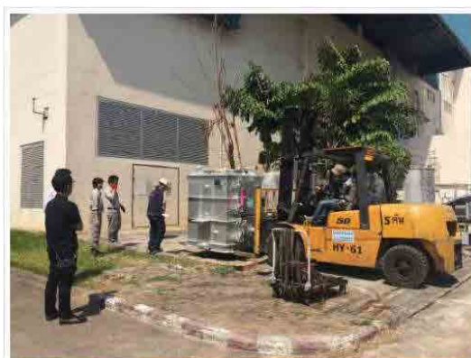
乾溜ガス化炉の据付
