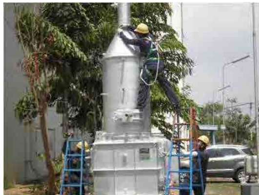
安全帯を付けて作業安全を確保
