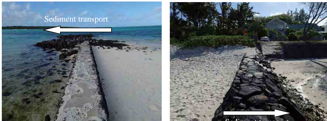
図 1.1.2 突堤の両側の海浜地形の違い
