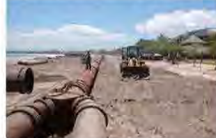
写真2 排砂管の敷設
