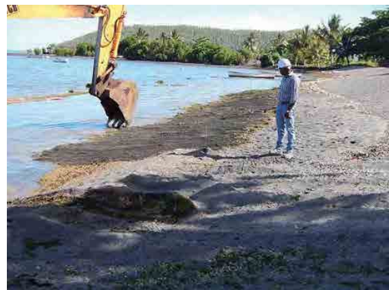
(6)砂材敷均し(2013年12月)
