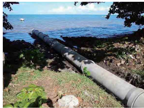
(4)排水管の敷設(2013年11月)
