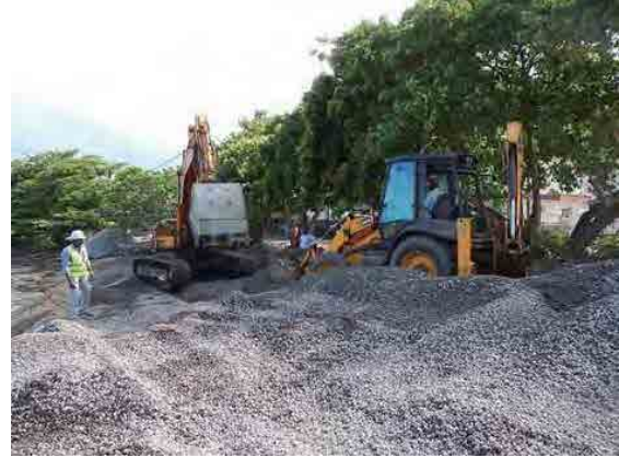
(2)礫材の敷均し(2013年11月)
